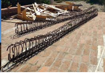
Enfierradura para vigas
