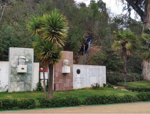
Acceso a sendero Siete Hermanas. Se encuentra en el acceso principal de la Quinta Vergara. Si bien es un paso informal, su uso está generalizado y se dan facilidades para su empleo.
