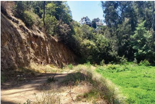
Sector 2do desarenador. Talud en el cerro.
