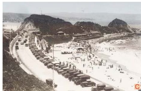
Camino contruido, Balneario las Salinas 1930
