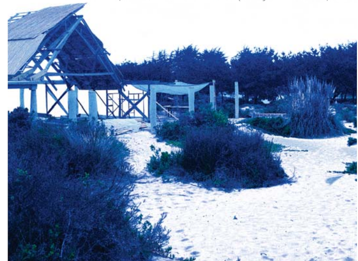
Construcción experimental, hace uso de moldaje flexible para elaborar columnas en hormigón con formas no convencionales, y estructuralmente funcionales. Fuente de la imagen: Autora
