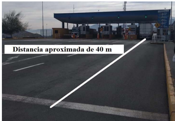
Figura 4.24: Medición de distancia desde línea de detención en terreno Fuente: Elaboración propia, 2019
