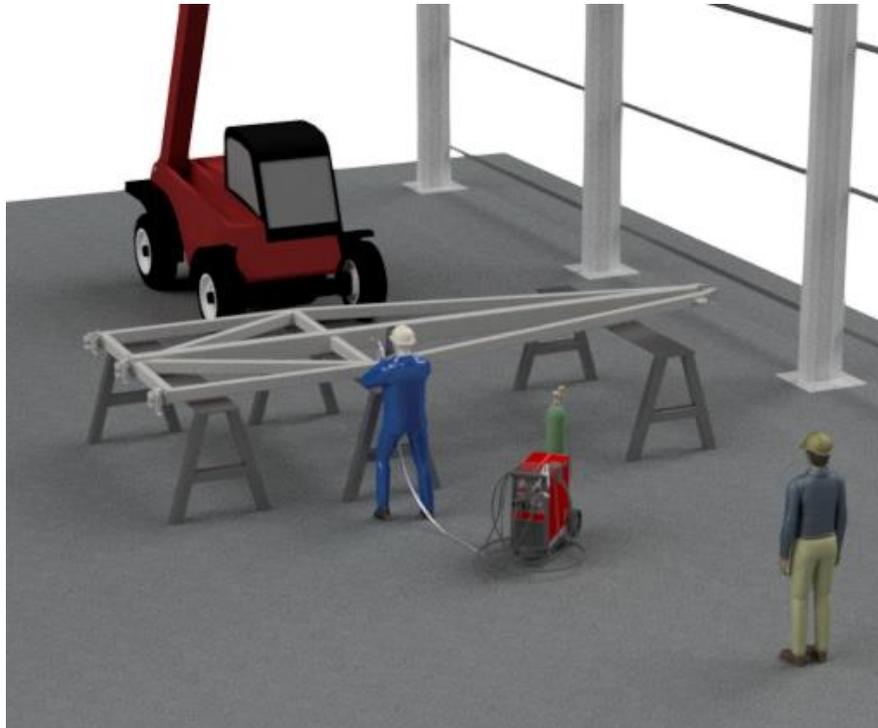
*Figura 4.6: Montaje de pilar, actividad 2.1. Fuente: elaboración propia.*
