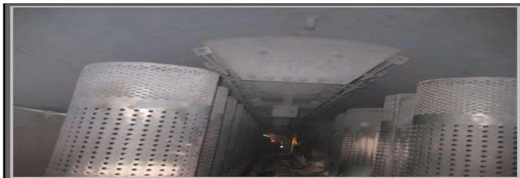
Figura 22 sedimento gris, Fuente: Informe técnico de inspección de caldera, Celulosa Arauco.
