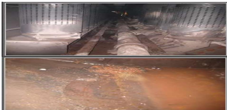
Figura 23 Capa de óxido luego de remoción de depósitos, Fuente: Informe técnico de inspección de caldera, Celulosa Arauco.
