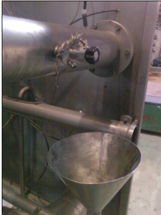
Fig. 3.1 Toma muestra de mosto frio.
