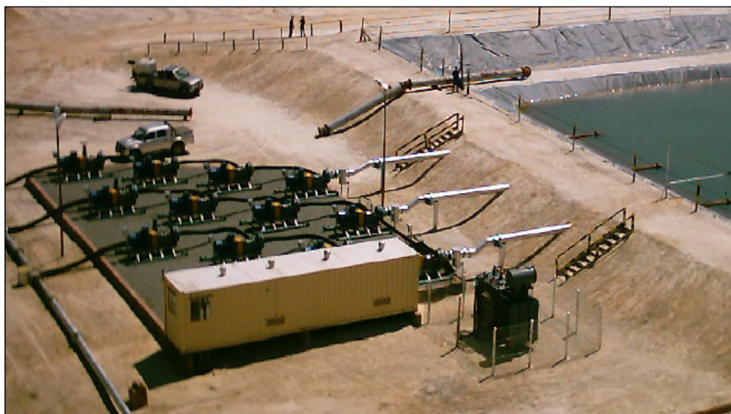
Figura 4-33. Estanque excavado para suministro de agua
