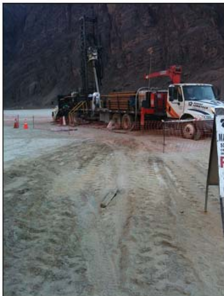
Figura 3-13. Proceso de perforación
