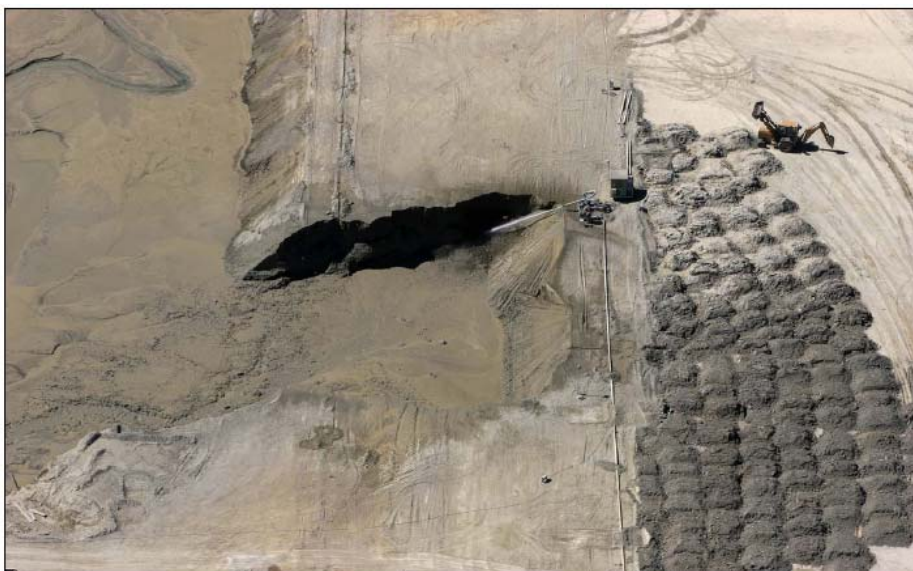
Figura 5-38. Operación de pitoneo en tranque de relave
