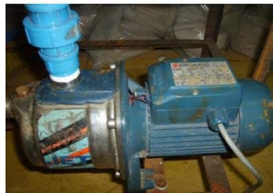
**Ilustración 22: Bomba centrífuga.**
