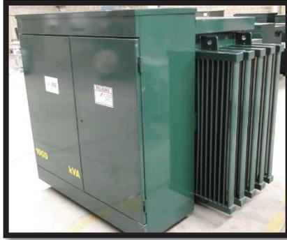
Figura 1-9: Transformador tipo pedestal [28].
