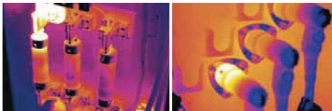
Figura 2-7: Inspección térmica para una conexión recalentada [38].
