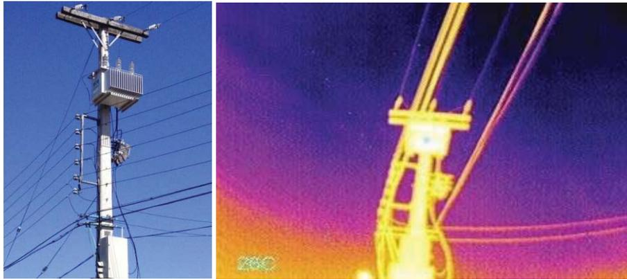
Figura 4-2: Fotografía del transformador de distribución A en luz visible y en infrarrojo.
