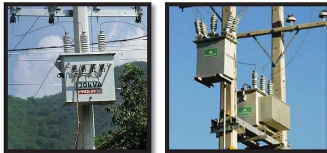
Figura 1-10: Transformador tipo poste, montado sobre un poste y sobre dos postes [28].
