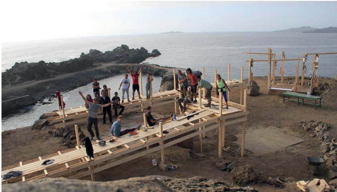
foto obra travesia chungungo
