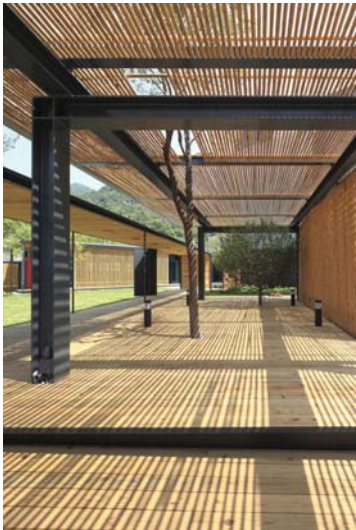
Las circulaciones poseen el entramado deseado para el proyecto de Jardín Infantil Blanca Nieves, por lo que se pone especial atención a la estructura que soporta la cubierta.
