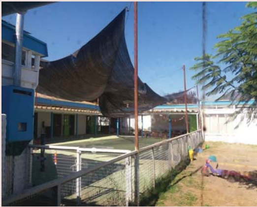
Interior del Jardín Infantil. Patio principal y patio de tierra con reja de separación. Malla para sombra.
