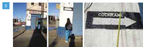
Señalética: Cochrane (Calle Cochrane con Wheelwright) Dimensiones: 30 cms x 78 cms. Distancia respecto al suelo: 2.26 mts Materialidad: Pintura negra para el fondo y blanca para el texto. Soporte: pintada sobre el muro Legibilidad: Baja Observaciones generales: La señal esta mal amtenida, esta deformada.
