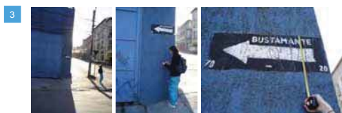
Señalética: Bustamante (Calle Bustamante con Carampagne) Dimensiones: 30 cms x 75 cms. Distancia respecto al suelo: 2.02 mts Materialidad: Pintura negra para el fondo y blanca para el texto. Soporte: pintada sobre el muro Legibilidad: Media Observaciones generales: La pintura del muro cae sobre la señal; la materialidad rugosa del muro, hace que sea aun más difícil de leer.
