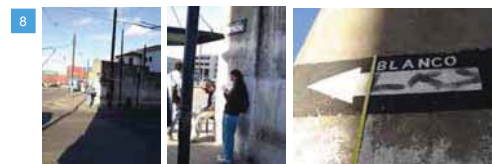
Señalética: Blanco (Calle CBlanco con Wheelwright) Dimensiones: 29 cms x 76 cms. Distancia respecto al suelo: 2.30 mts Materialidad: Pintura negra para el fondo y blanca para el texto. Soporte: pintada sobre el muro Legibilidad: Baja Observaciones generales: La señal necesita mantención. Delente de ella hay un techo que afecta en su visibilidad.
