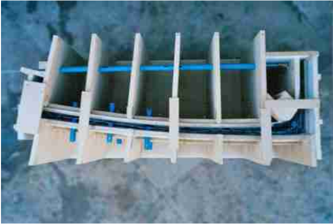
vistas matriz cerrada, lista para el vaciado
