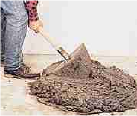
mezcla manual del concreto
