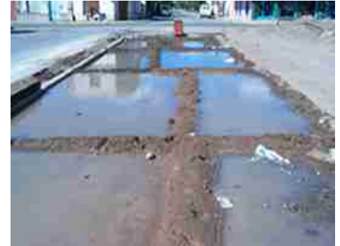
curado por inundación
