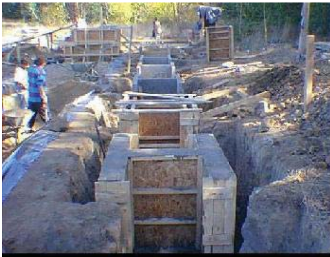
Figura 3.2: Vista de los instalación piloto durante su construcción.
