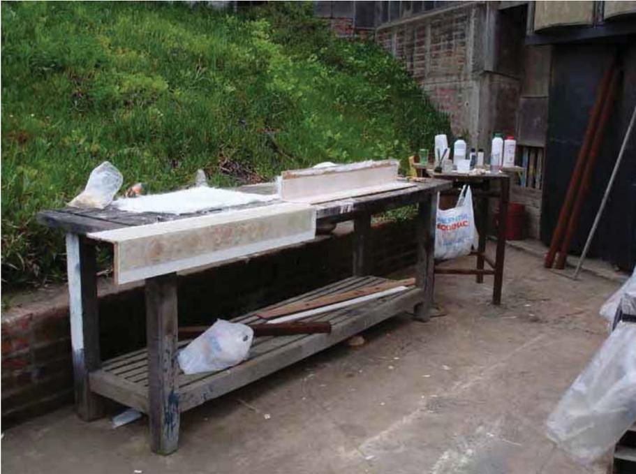
La fibra se trabaja con 4 elementos: la fibra, en estado de "alfombra", la resina, que une la fibra; el acelerante, que acelera el fraguado o gelado de la resina y el catalizador, que activa el acelerante. El litro de resina se divide en partes iguales. En una parte se aplica con jeringa 7cc. de acelerante, a la otra parte se le agrega 3,5cc. de catalizador para así ir mezclando las cantidades que de a poco se vayan a usar.
