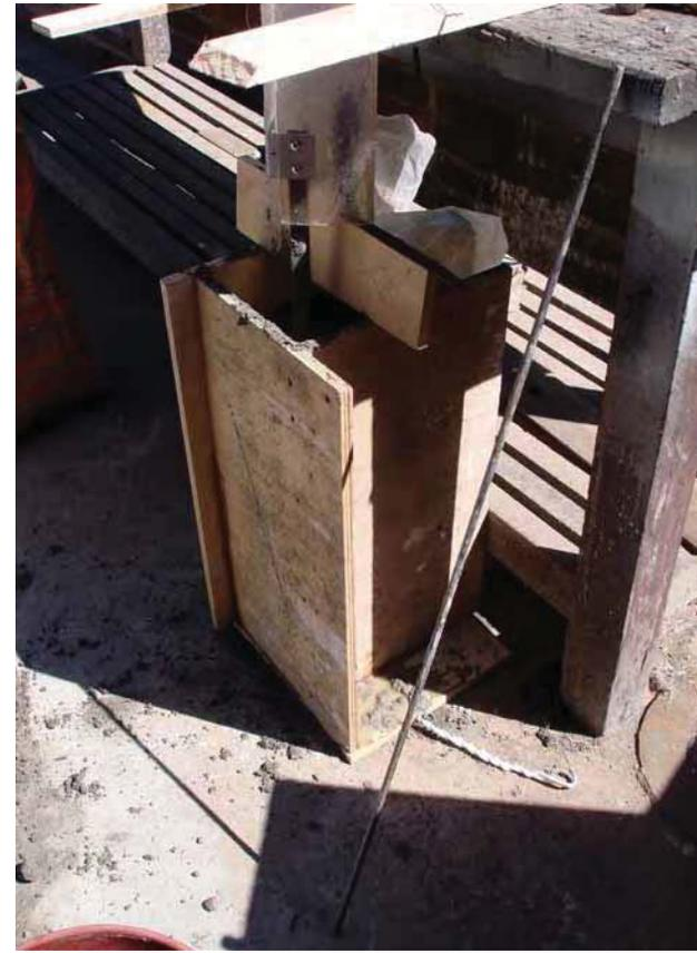
Para el vaciado en concreto se construyó un moldaje que soportara el peso. Las medidas son de 25cm. x 25cm. de base, por 60cm. de profundidad. Se utilizó mezcla para piso, con gravilla de menor espesor, utilizando un saco de 45kg.
