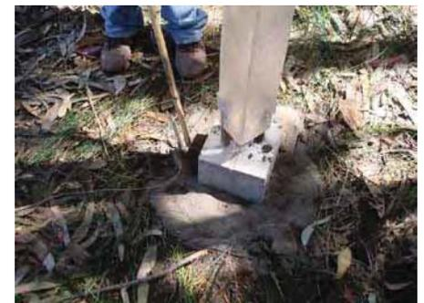
Debido al peso del prototipo, fue necesario terminar de unirlo con remaches, una vez que la base ya estuviese ubicada y previamente nivelada.
