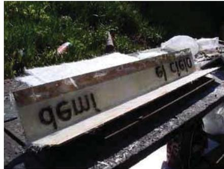
Luego se aplica una delgada capa de resina, la cual se deja gelar, no completamente, para así, poner a continuación la primera capa de fibra y a continuación la segunda y tercera. Los módulos se realizaron con 3 capas de fibra, para así asegurar su resistencia al viento. El tiempo total de gelado de la resina depende de la temperatura ambiente y la cantidad de sol. Se recomienda trabajar al aire libre para evitar una intoxicación, al igual que con mascarilla, guantes y delantal.
