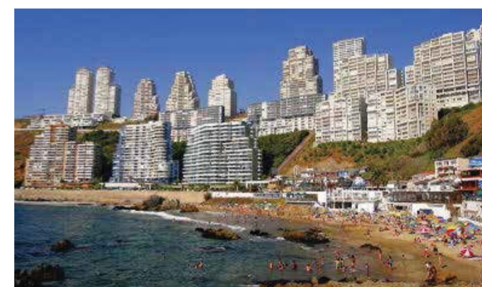
Figura 21. Playa Cocha en la actualidad / Imagen: http://www.construhub.cl/destacados/apetecido-borde-costero/
