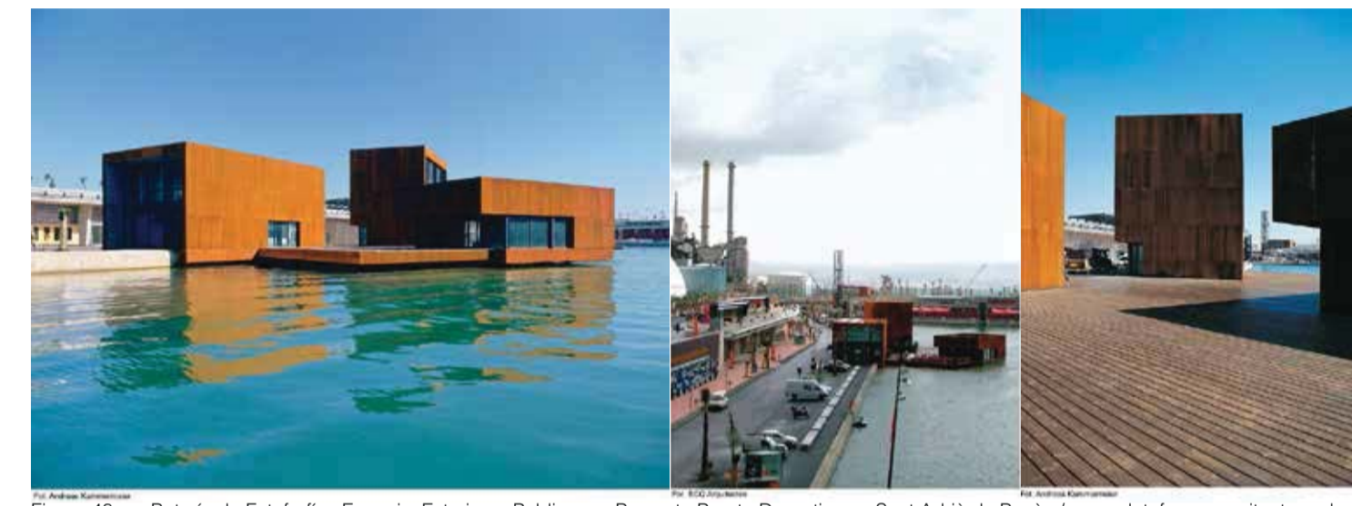
Figura 48. Bateria de Fotografías Espacios Exteriores Públicos - Proyecto Puerto Deportivo en Sant Adrià de Besòs / www.plataformaarquitectura.cl
