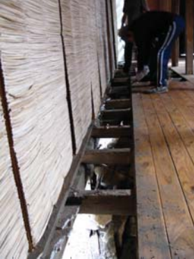
IMG.107 desarme de piso
