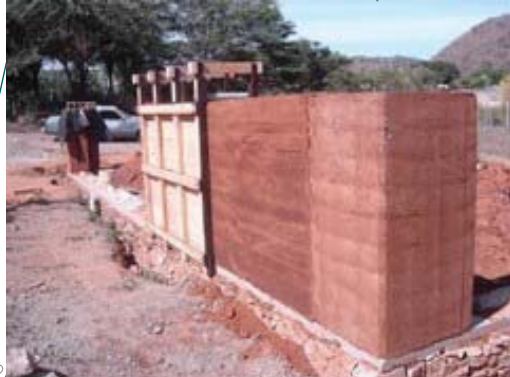
IMG.103 encofrados y prensas en bloque
