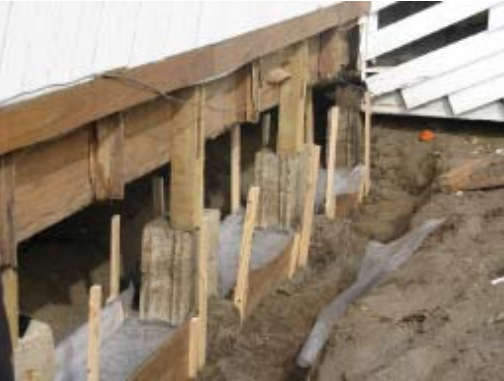
IMG.123 emplantillado
