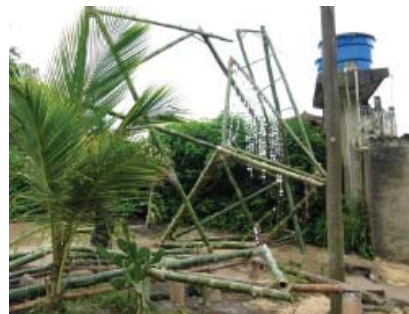
IMG.104 coretto terminado
