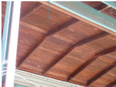
IMG.38 detalle techumbre
