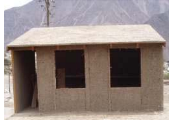
IMG.96 viviendas terminadas en quincha
