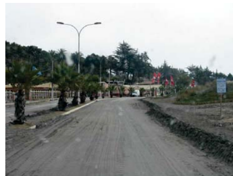
IMG.03 zona inundada_sector costanera
