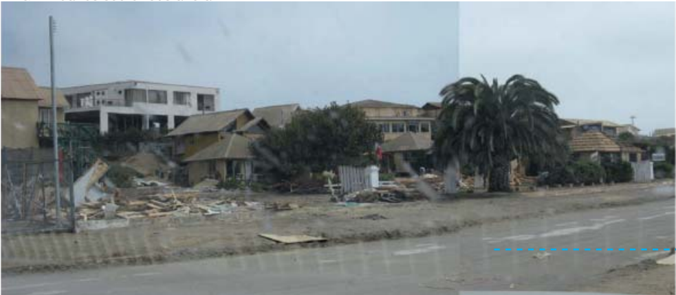
IMG.22 daños sector costanera
