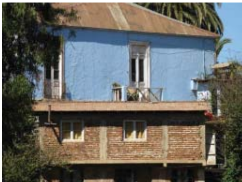
IMG.27 viviendas colindantes
