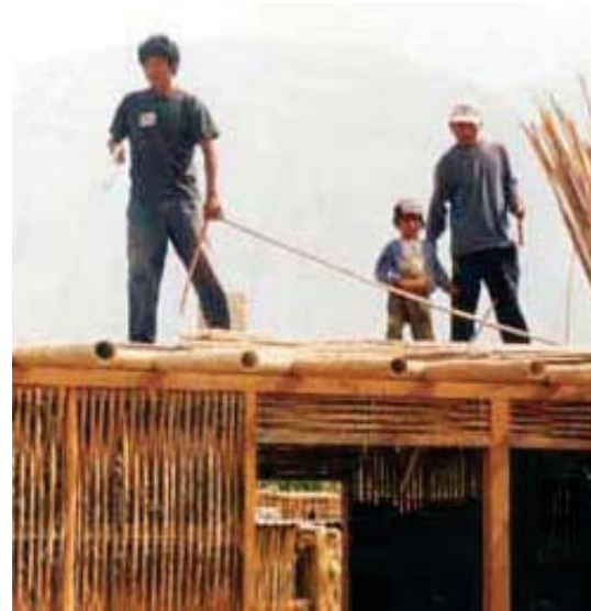
IMG.89 vivienda en estructura de paneles
