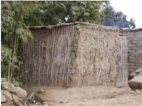
IMG.61 estructura exterior
