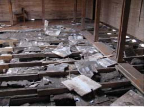
IMG.109 desarme de piso
