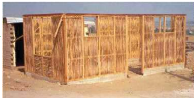
IMG.88 vivienda en estructura de paneles
