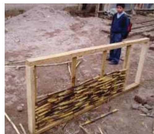
IMG.78 construcción de paneles
