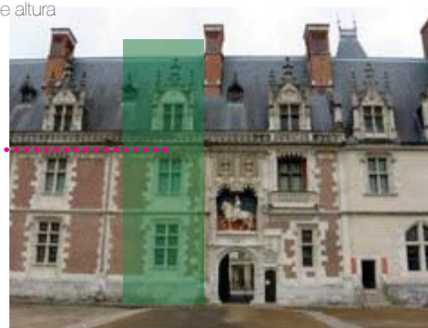
IMG.32 Fachada castillo de Blois
