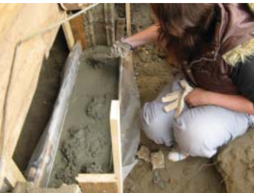
IMG.124 emplantillado
