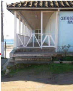
IMG.31 corredor del 1900
