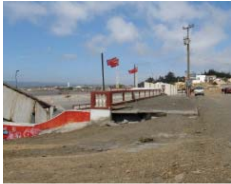
IMG.16 daños caleta de pescadores
