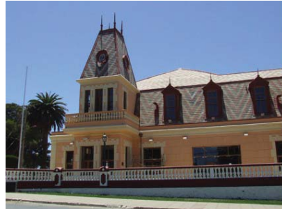
IMG.13 estado del edificio actualmente
