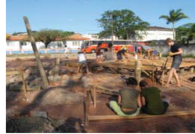
CALCE Y POSTURA DEL TABLERO SOBRE LOS ROLLIZOS
