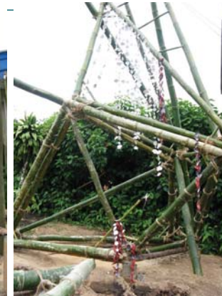
IMG.100 estructura coretto
