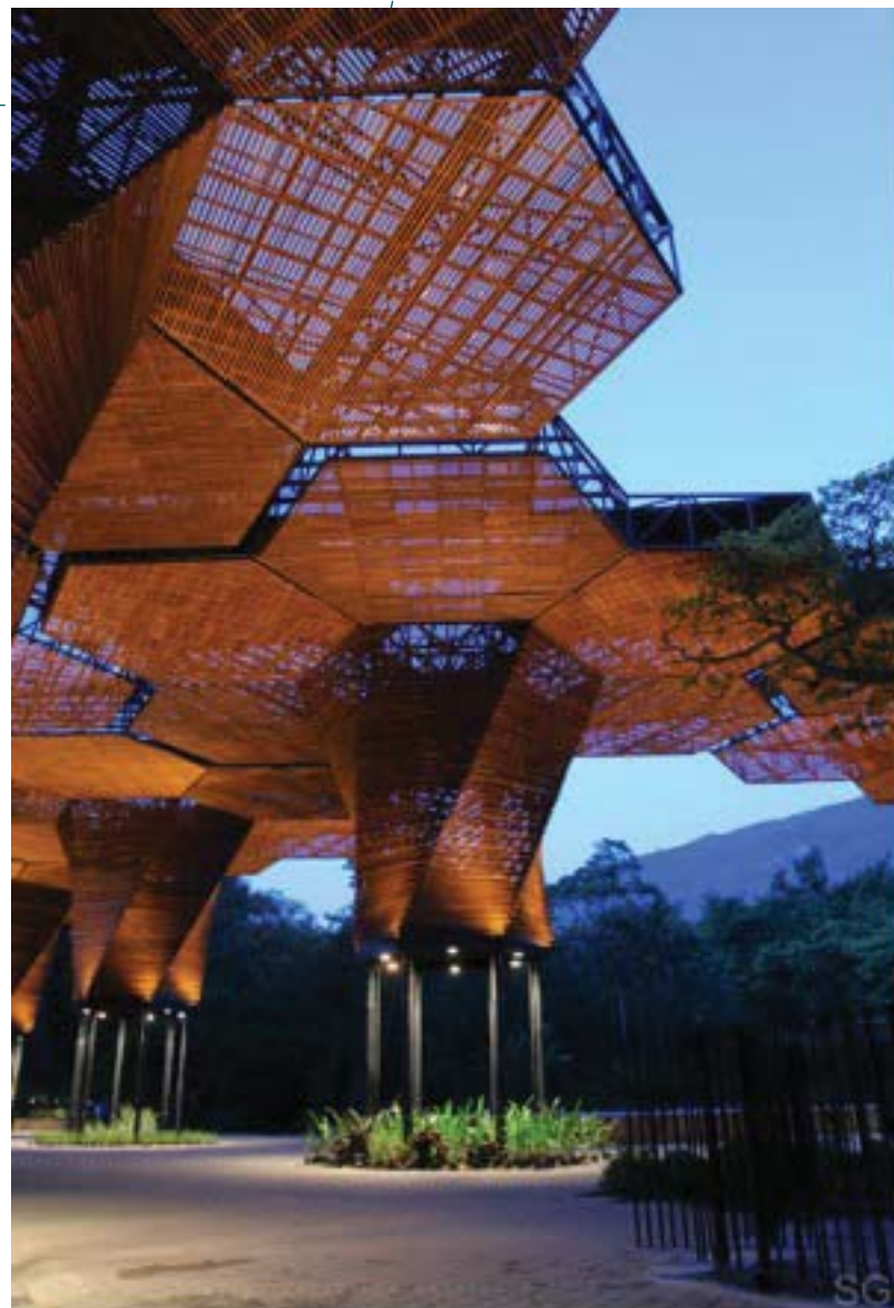
IMG.34 iluminación de la cubierta
