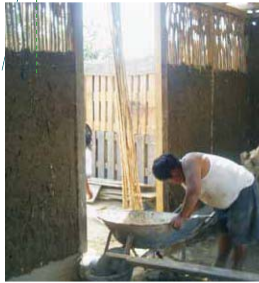
IMG.91 revestimiento de adobe en paneles
