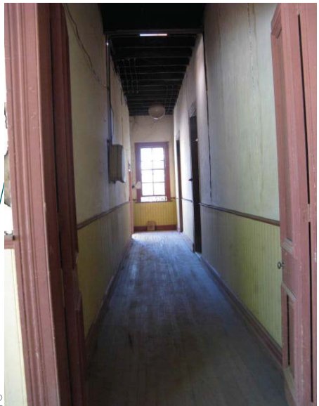
IMG.22 corredor interior
