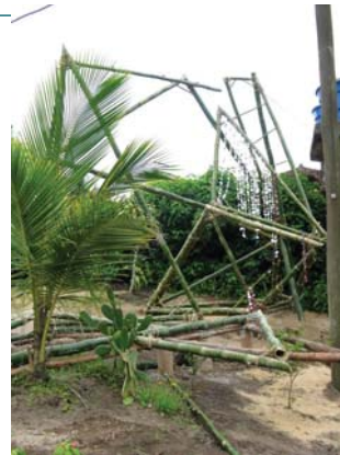
IMG.99 estructura coretto
