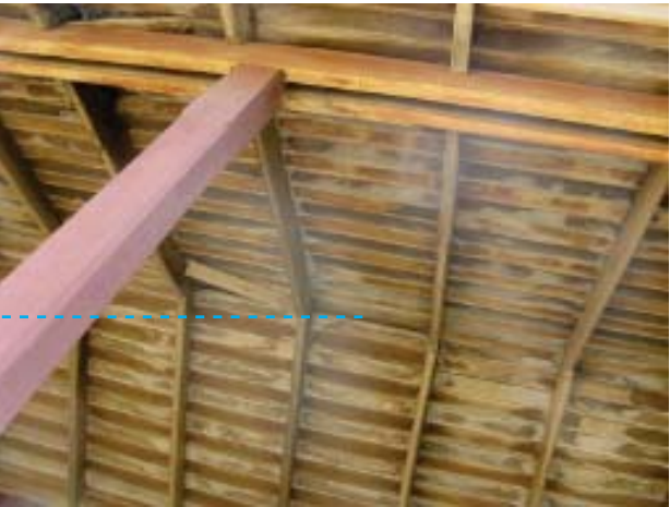
IMG.13 detalle techumbre
