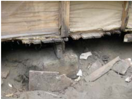
IMG.115 corte del revestimiento exterior
