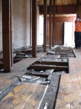
IMG.108 desarme de piso
