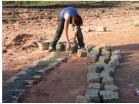
TRAZADO DE LOS SUELOS CON ADOQUINES
