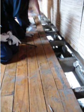
IMG.106 desarme de piso
