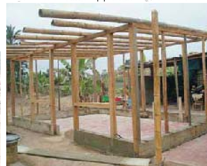
IMG.75 pie derechos y su estructura completa
