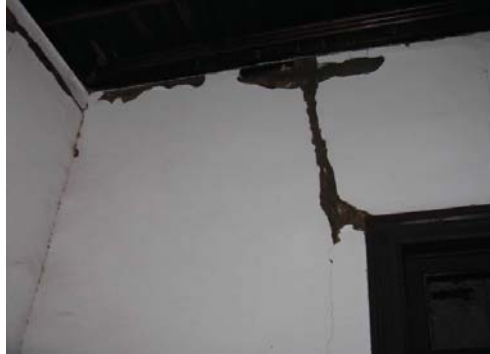
IMG.39 muros en adobe
