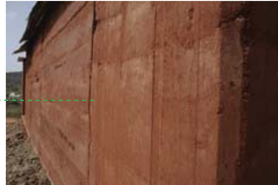
IMG.107 detalle terminación del muro
