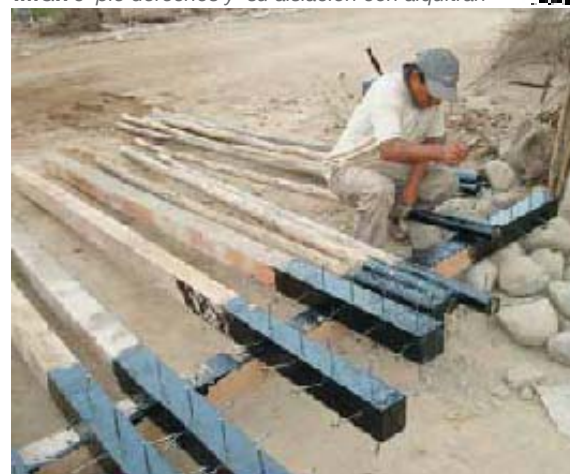
IMG.70 pie derechos y su aislación con alquitrán
