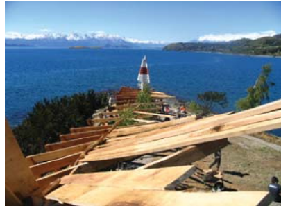
IMG.10 vista de la estructura y el paisaje
