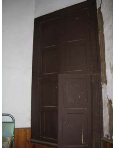
IMG.41 muros en adobe
