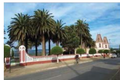
IMG.15 parque y su entrada cercada por balaustradas
