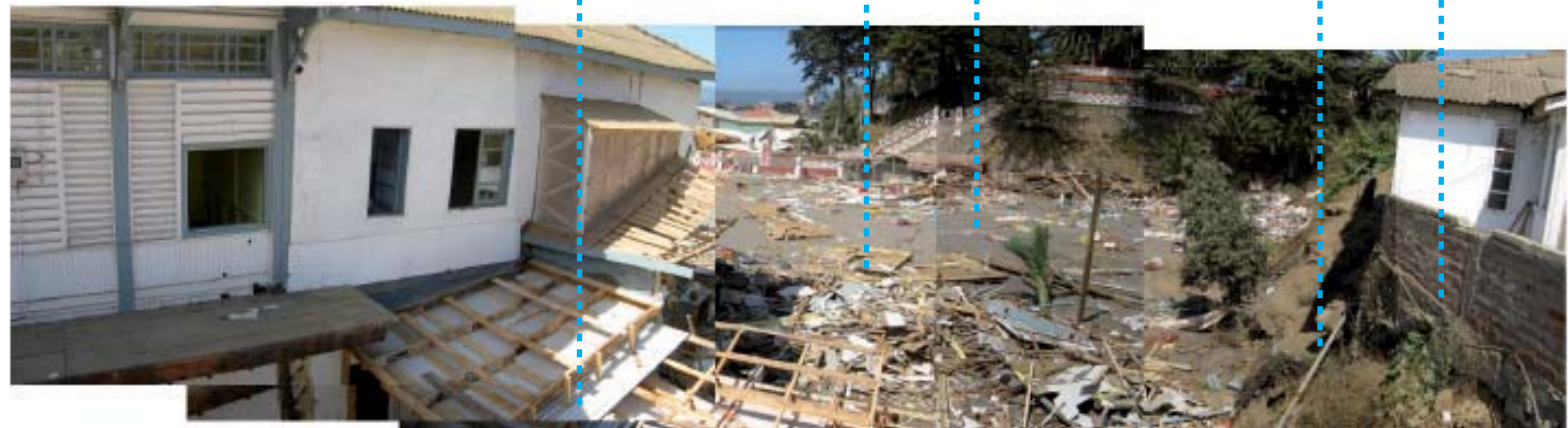
IMG.11 daños en sector del tsunami
