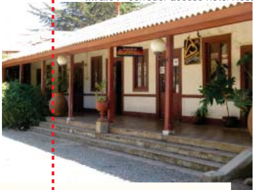
IMG.04 corredor acceso hotel Ross
