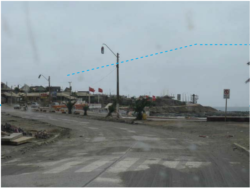
IMG.13 daños sector costero
