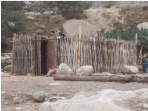
IMG.63 estructura exterior
