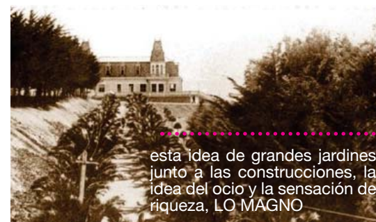
IMG.29 Edificio Casino
