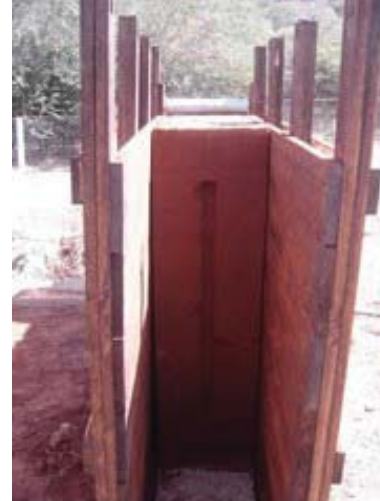
IMG.106 detalle muro
