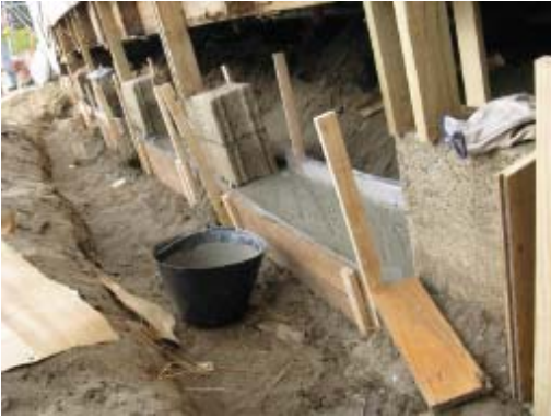
IMG.122 emplantillado
