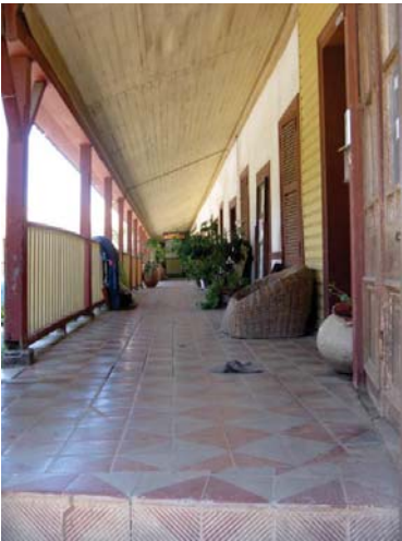
IMG.10 corredor de acceso
