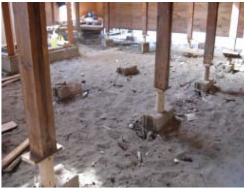
IMG.111 soporte de pilares estructurales
