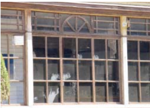
IMG.03 detalle ventana hotel Ross
