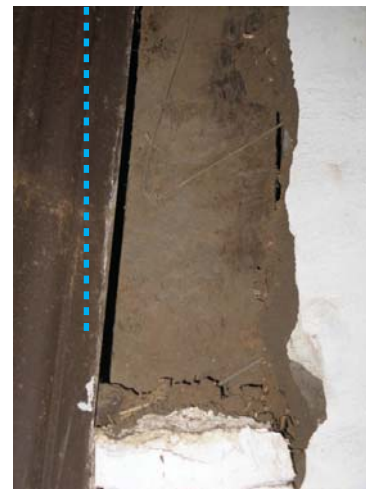
IMG.45 muros en adobe
