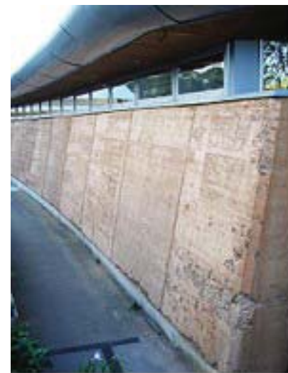
IMG.109 detalle terminación del muro
