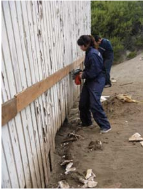
IMG.118 corte revestimiento
