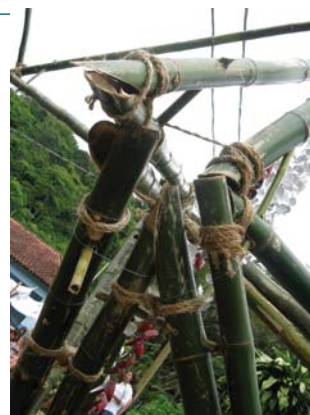
IMG.97 estructura coretto
