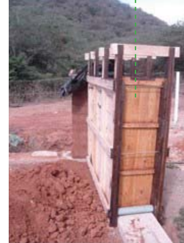
IMG.106 detalle encofrado
