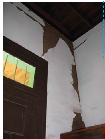
IMG.44 muros en adobe
