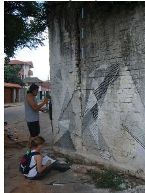
IMG.75 faenas en el lugar, trabajos realizados
