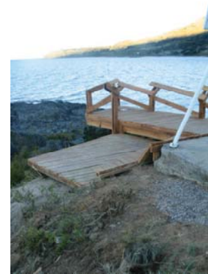
IMG.12 muelle de la obra
