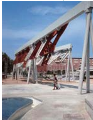
IMG.13 estructuras de alero
