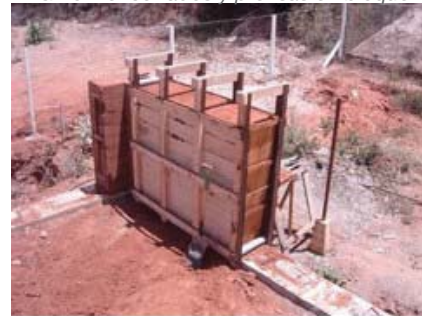
IMG.102 encofrados y prensas en bloque
