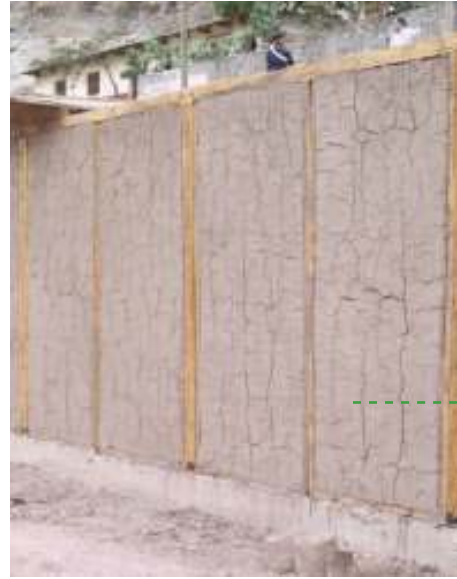
IMG.92 revestimiento de adobe en paneles
