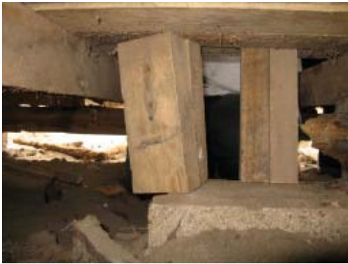
IMG.110 soporte de pilares estructurales
