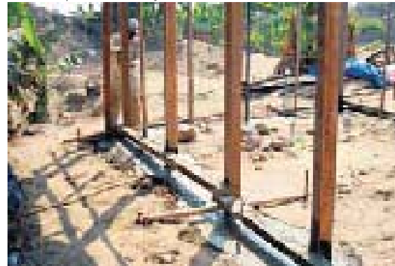
IMG.74 pie derechos y su instalación
