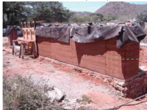
IMG.104 terminación del bloque bloque
