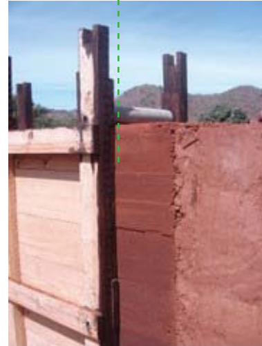
IMG.105 detalle muro
