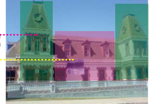
IMG.24 Fachada del Casino Ross, Pichilemu
