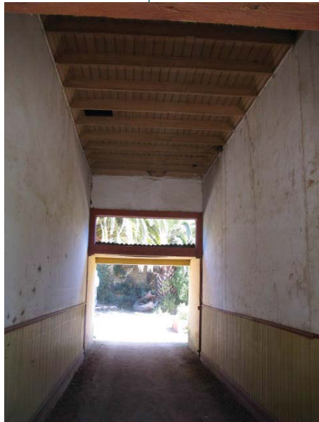
IMG.21 corredor interior
