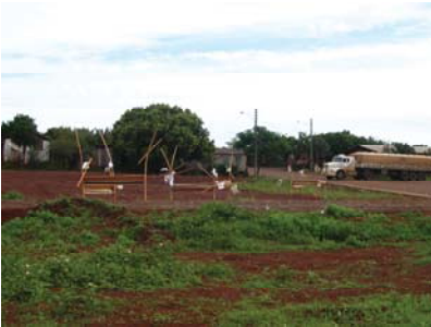
IMG.34 vista obra terminada
