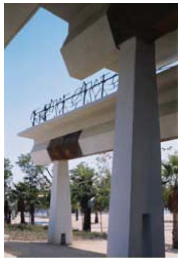
IMG.15 detalles de las columnas
