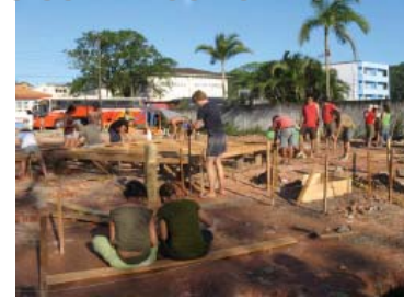
CALCE Y POSTURA DEL TABLERO SOBRE LOS ROLLIZOS
