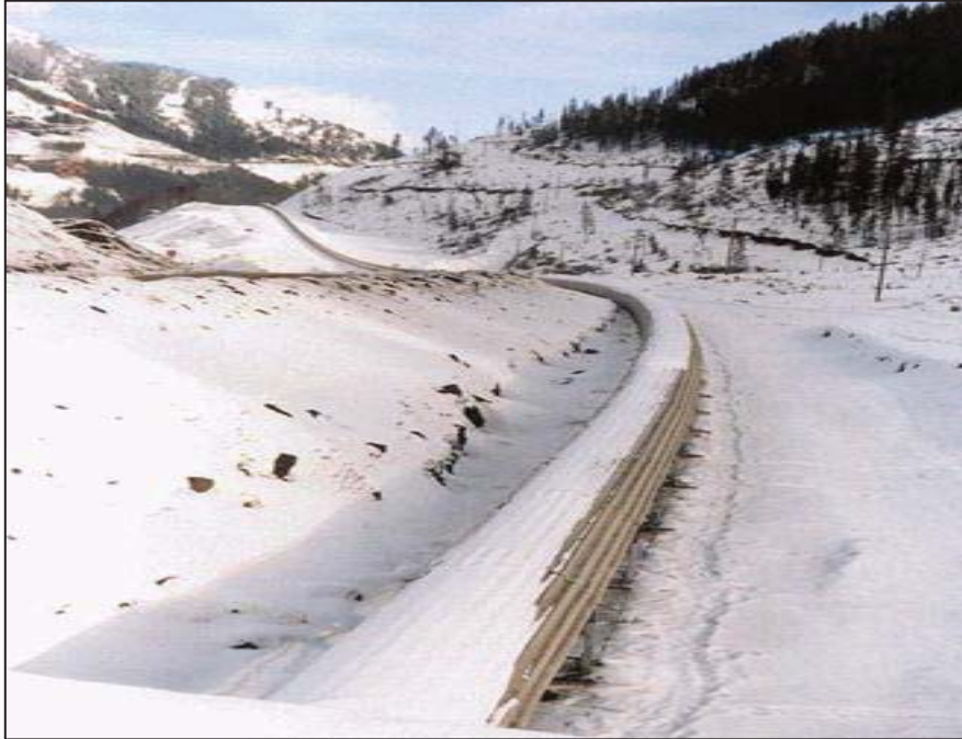
Figura 6-1. Instalación de Metso Rope Conveyor
