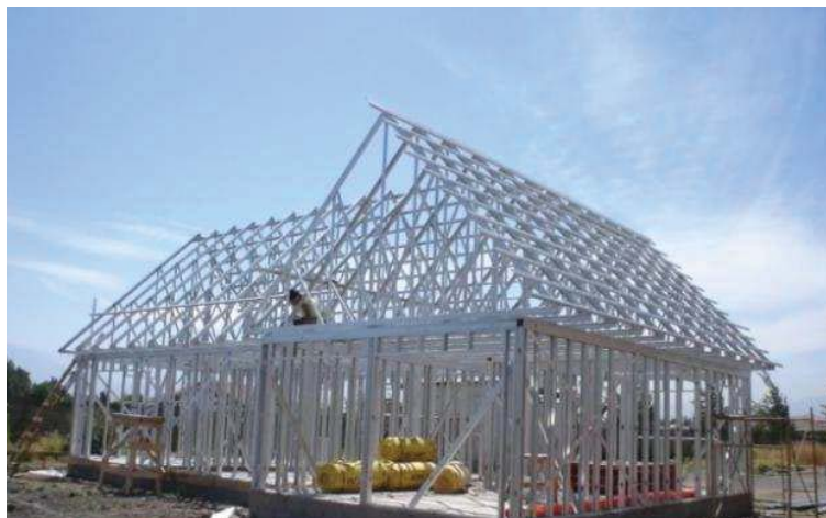
Figura 38. Puentes térmicos en Metalcom. Fuente: casascanadienseschile.cl
