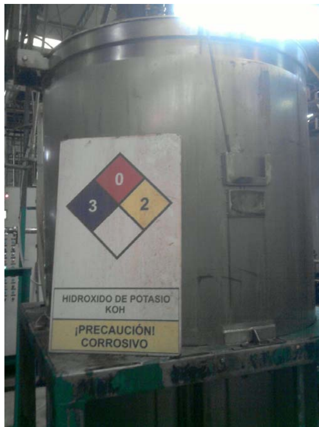
Figura 30: Estanque de almacenamiento interno de KOH.
