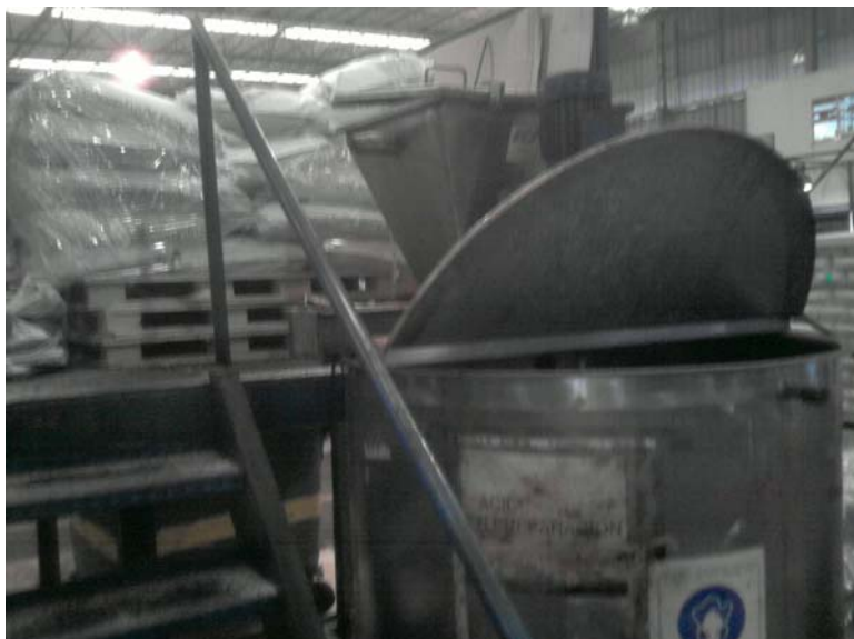
Figura 32: Estanque de mezclamiento entre el Ácido (sólido) y agua de proceso.
