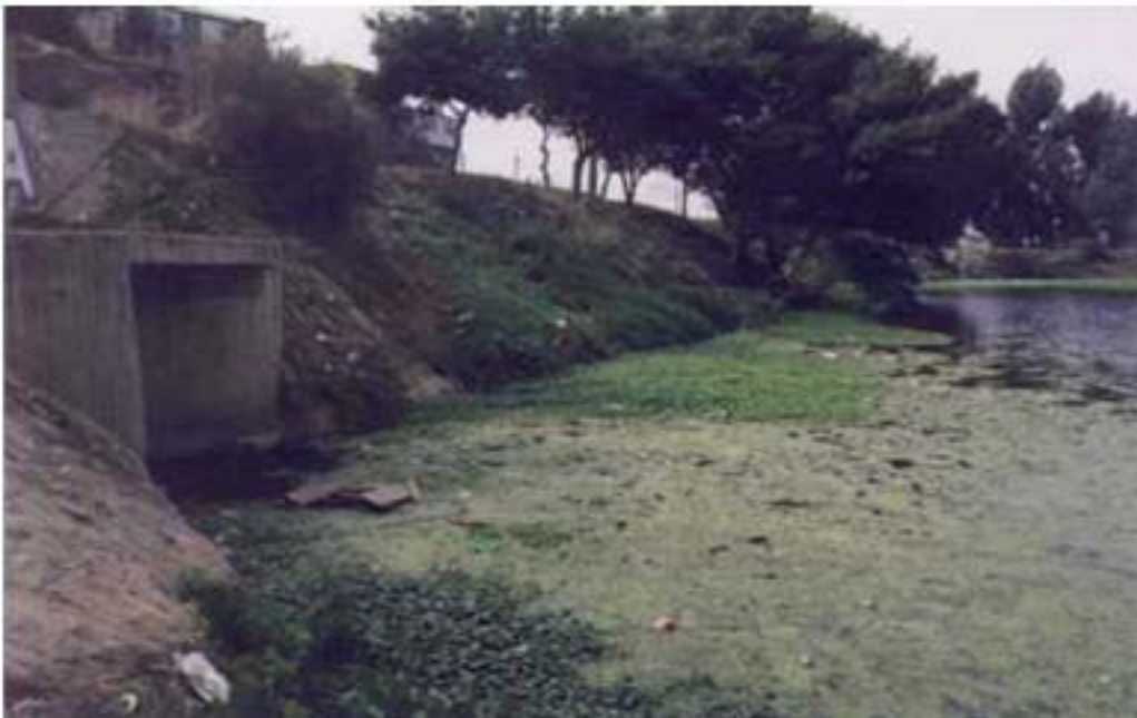
Figura 3-4: Canal de evacuación de las aguas del Tranque Forestal.
