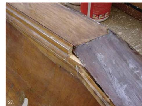
Prueba de encaje de las partes, durante el proceso de rebaje del larguero.
