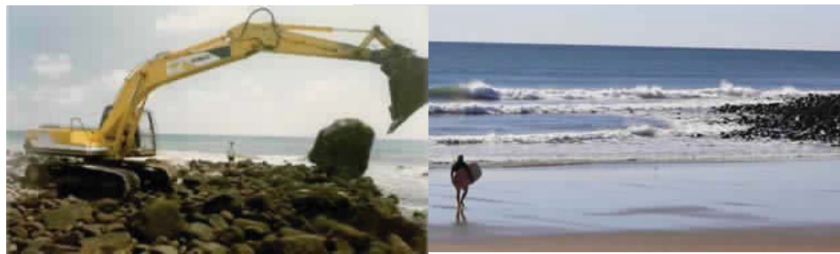
Fig. n 114 y n 115: Procedimiento y estado final, de la actuación (ambas en bajamar. Fuente Fundación surfrider,2015.
