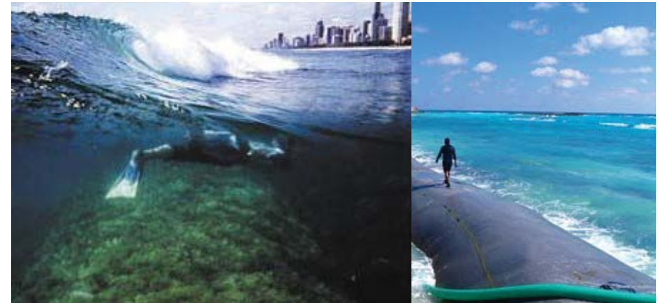
Fig. n 110: Arrecife artificial de sacos de arena.
