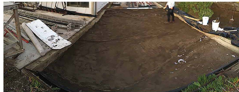
Fig. n 218: Estabilizado del relleno de arena al nivel de las cotas.
