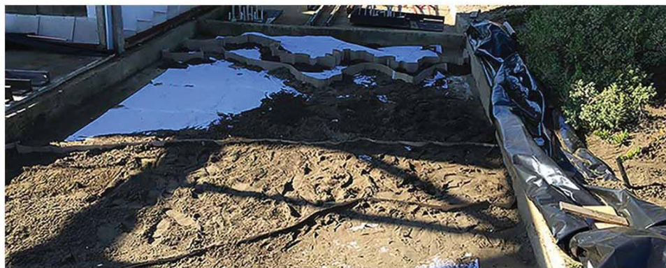
Fig. n 215: Proceso relleno de cotas de nivel.
