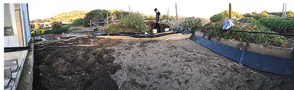
Fig. n 217: Relleno de arena.
