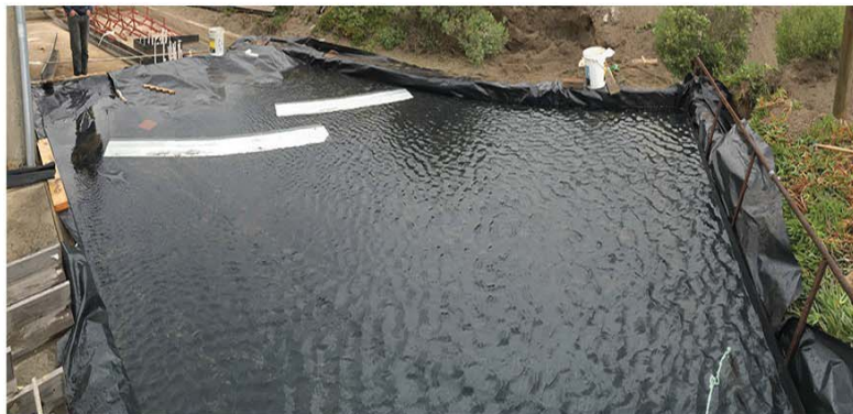
Fig. n 221: 100 % nivel de llenado de agua.
