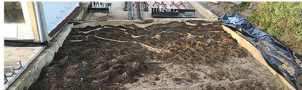
Fig. n 216: Relleno de arena.
