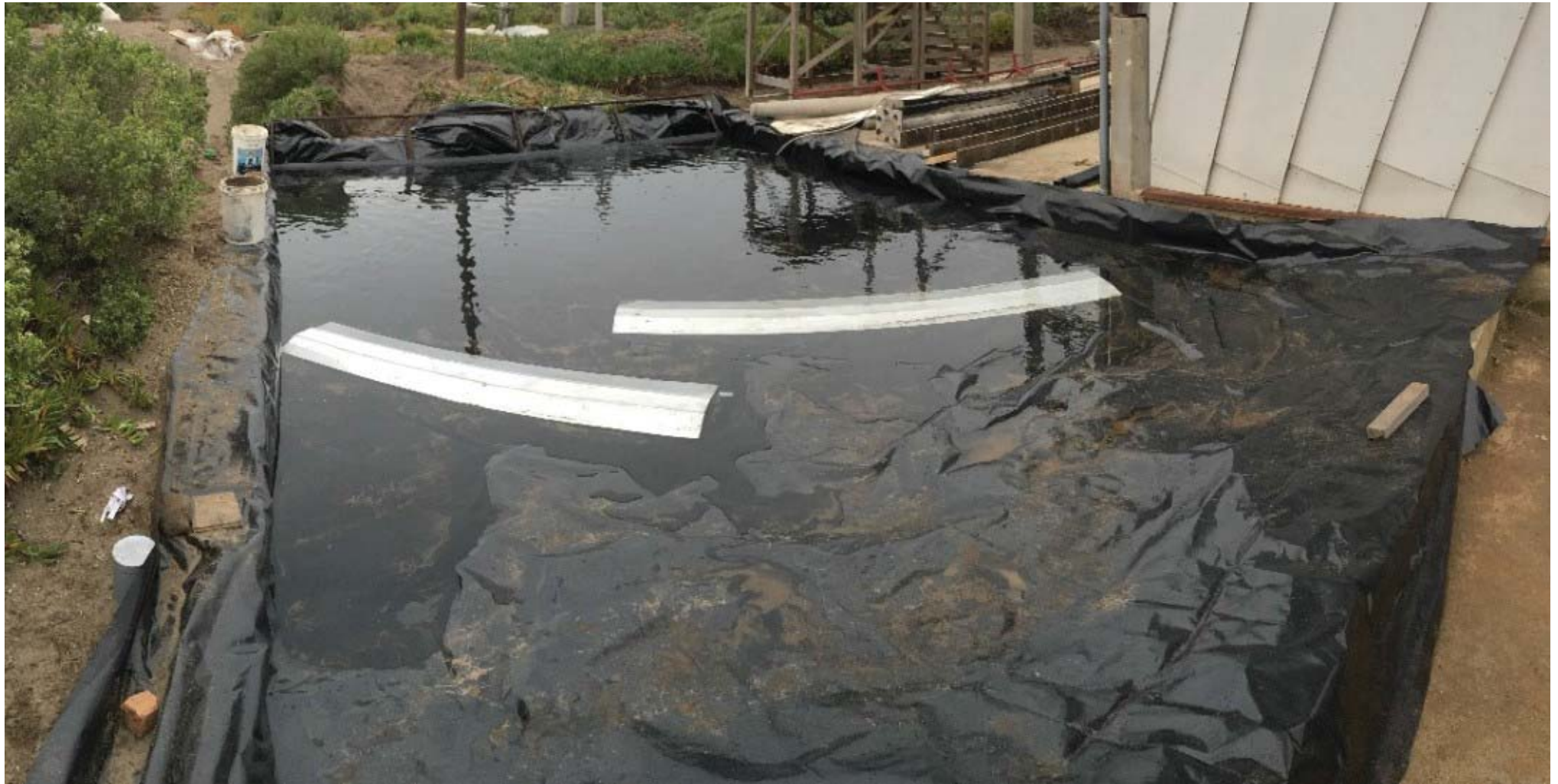
Fig. n 187: Cubierta con polietileno, negro, rellena con agua, y en posición los rompeolas sumergidos. Fuente propia.
