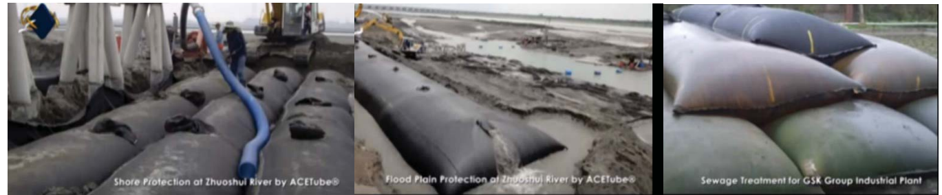
Figura n° 234 Referente del llenado de geotextiles mediante bombas de 4". Fuente: ACETube.
