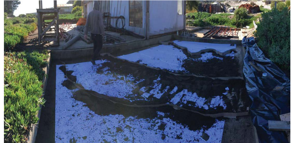
Fig. n 185: Cotas con altura final, rellenos con arena de playa. Fuente propia.
