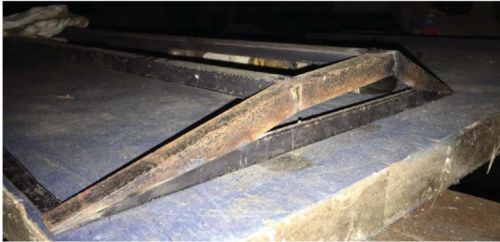
Fig. n 183: Perfil construido en base a Ángulos laminados de acero soldado, con revestimiento de zinc remachad. Fuente propia.
