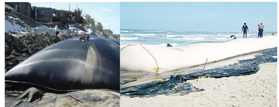
Fig. n 111: Geotextiles utilizados para contenciones en ambientes marítimos.
