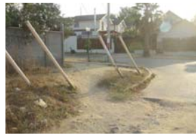
Sin pavimentar, terreno irregular.
