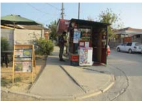
Desnivel no llega a ras del nivel de calle. Borde no señalado (color)
