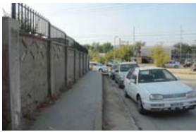
Ancho menor a lo requerido para implementar una huella podotactil. Desnivel no señalado (color)
