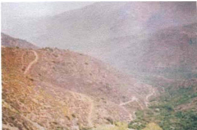
Foto 1. Camino de acceso
