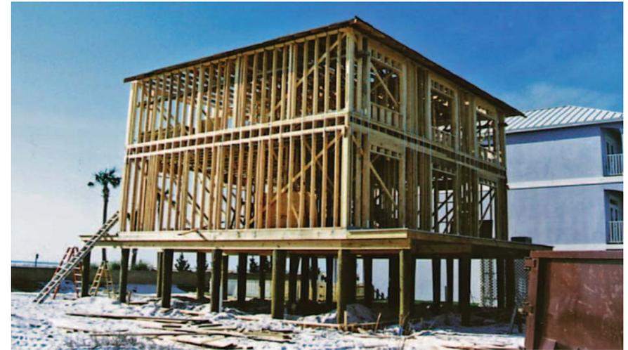
fig 210. Fundación típica de pilotes de madera.
