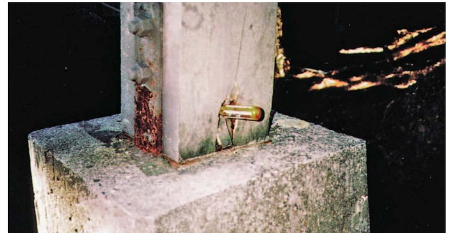
fig 211. Degradación de la madera en una fundación de concreto.
