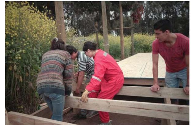
fig 119, 120. Construir la plataforma escenario de Ciudad Abierta. Desde los cimientos, rodillos, vigas, planchas y pintado.
