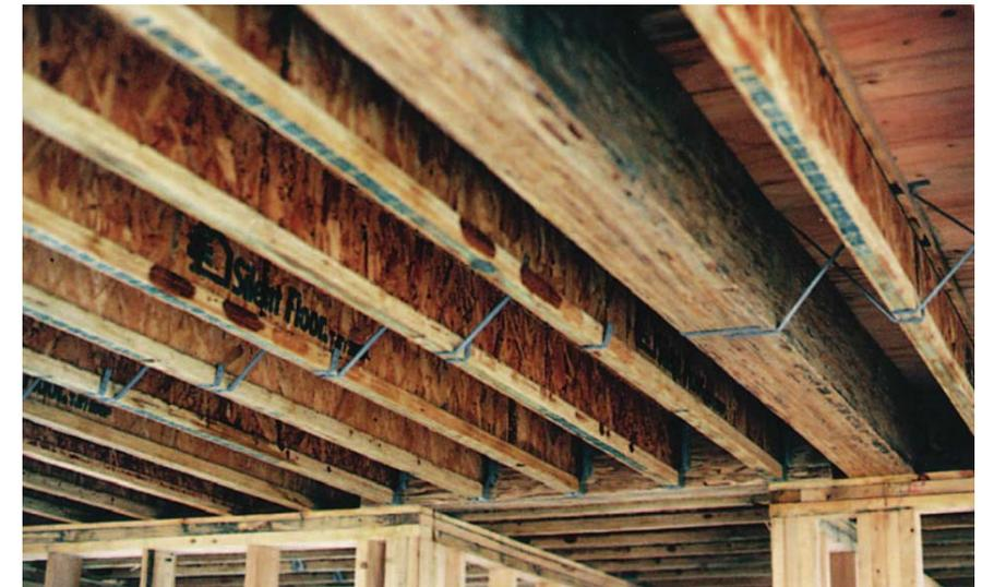
fig 214. Tensores para prevenir doblamiento de vigas.
