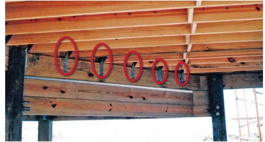
fig 213. Pletinas de anclaje en las vigas de suelo elevado.
