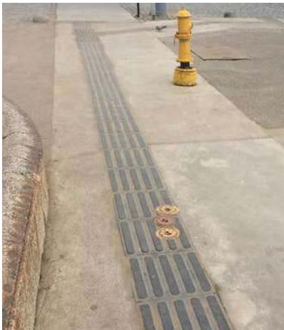
IMG.43. Baldosas de suelo táctil. Elaboración Propia
