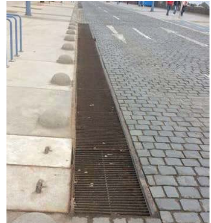
IMG.30. 3- Ductos de evacuación de aguas. Elaboración Propia
