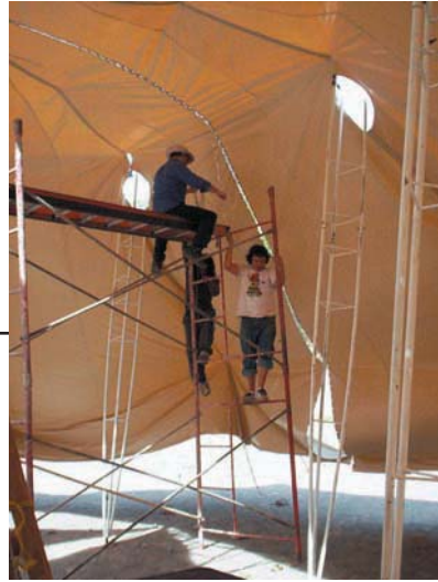
Al segundo día de montaje ,la jornada mas larga es vincular los cuatro mantos a los cable y entre si , efectuandose en toda una tarde
