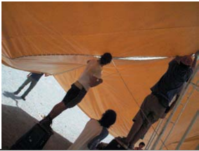
Al segundo día de montaje ,la jornada mas larga es vincular los cuatro mantos a los cable y entre si , efectuandose en toda una tarde
