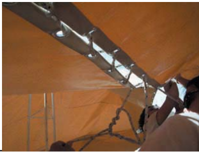
Al segundo día de montaje ,la jornada mas larga es vincular los cuatro mantos a los cable y entre si , efectuandose en toda una tarde
