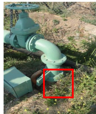
Posible Ubicación Pozo 3 Los Litres
