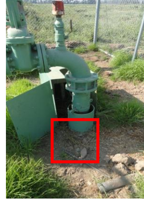
Posible Ubicación Pozo 4 Los Litres
