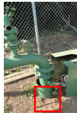
Posible Ubicación Pozo 6 Los Litres
