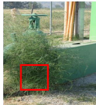
Posible Ubicación Pozo 5 Los Litres
