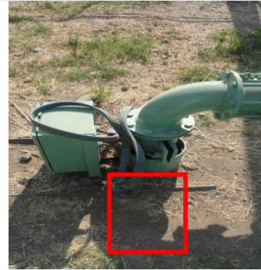
Posible Ubicación Pozo 1 Los Litres
