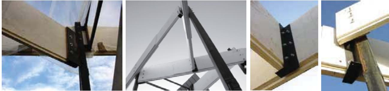
Viga diagonal; une los dos módulos que constituyen la «estructura chasis»
