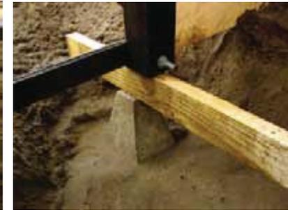
Apoyo definitivo; poyo de hormigón, enterrado en la arena, de base cuadrada de 30 cm y 47.5 cm de alto. En su parte superior disminuye a 8 cm y remata con un esparrago de 16 cm de alto
