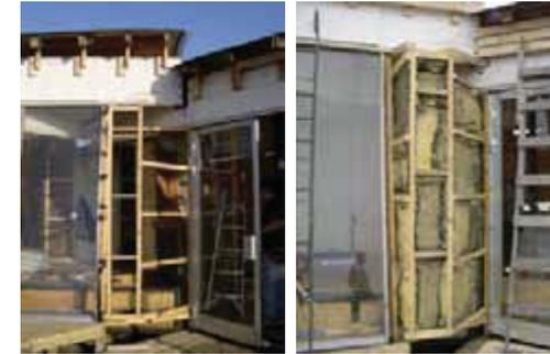
Bastidor que es la estructura principal de este revestimiento. Su aislación es con lana de vidrio reutilizada del cielo americano donados
