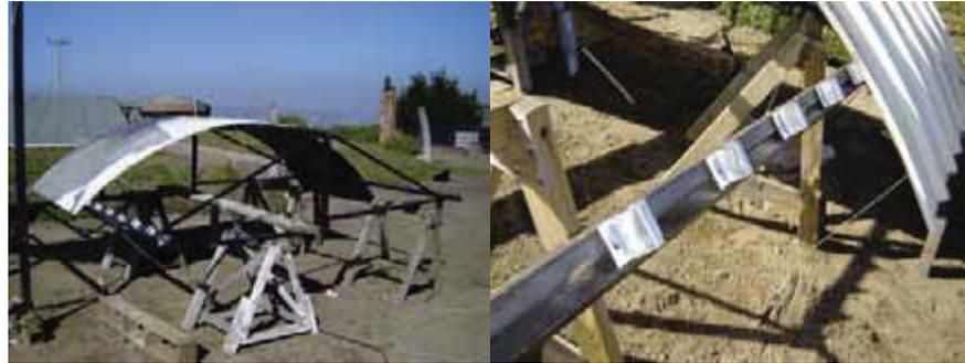
Estructura final revestida por los 6 paneles. Estos se fijan a la estructura de fierro a través de «clip omegas» (comprados en Hunter Douglas)
