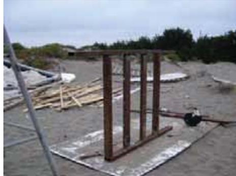
Estructura principal del baño. En base a fierros, se construye primero una estructura de suelo que va apoyada a través de «patas» al suelo y soldada a las vigas de suelo de la estructura chasis; desde ésta nacen las verticales que completan la estructura principal del baño, estas verticales se fijan a la viga de cajón mediante la estructura del techo del baño.
