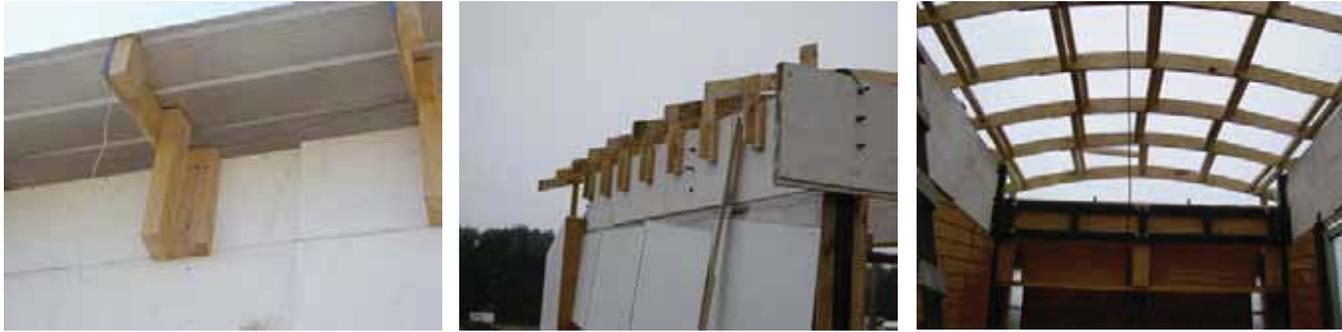
Tacos de madera fijados a la viga de cajón; soportan cada cercha de techo por ambos lados de la estructura chasis constituyendo el total de techo. Luego el caneado estructura el total de cerchas conformando el techo como un todo estructural; dividido en los dos niveles de la cubícula.
