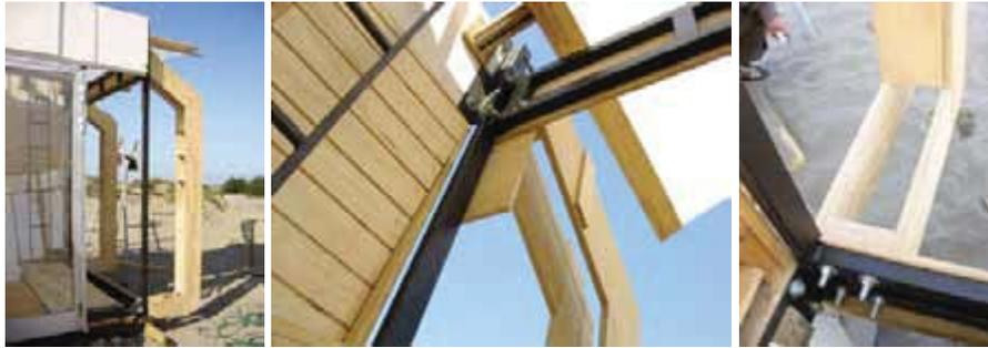
Vigas superior e inferior de donde «cuelga» la cocina y estructuran el cabezal de la «estructura chasis».
