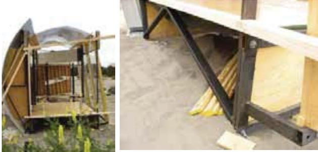
La «estructura chasis» no posee sus cabezales estructurados para recibir algún revestimiento, por esto construimos a nivel de suelo (con fierro) y a nivel de viga de cajón (con madera) la estructura principal del muro armario y que a la vez es estructurante de la «estructura chasis»
