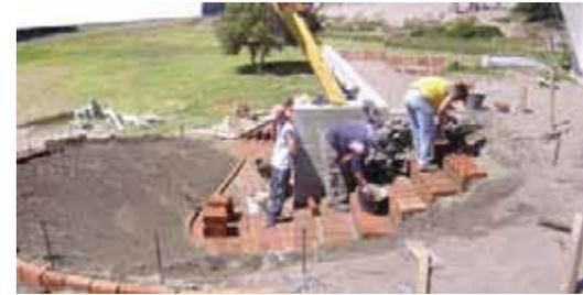
Postura de ladrillos en el terreno ya preparado (dibujado y compactado).
