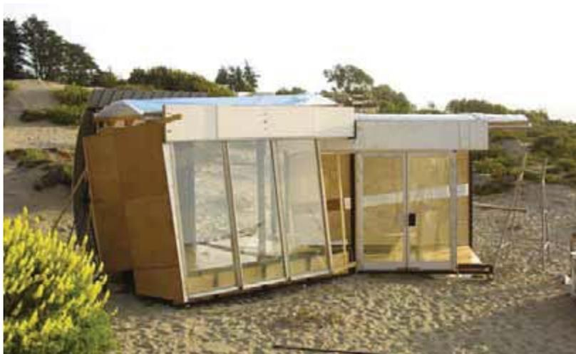
Contamos con la ayuda de un grupo de alumnos de 2º año para llevar a cabo faenas predeterminadas como las de los revestimientos (aislación e impermeabilización de muros) y el traslado de los paneles de suelo y cocina desde el taller de diseño al lugar de la obra.
