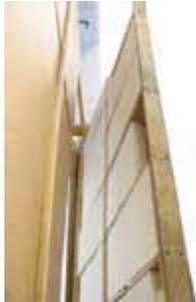
Aislación y revestimiento interior del muro armario.
