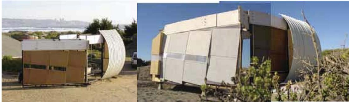
*Panel ya incrustado, definiendo los limites del frente opaco. Posteriormente vendrá su revestimiento exterior e interior diferenciando el dentro del afuera.*
