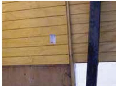
*Instalación eléctrica realizada en la Cubícula por el interior de los paneles de revestimiento.*
