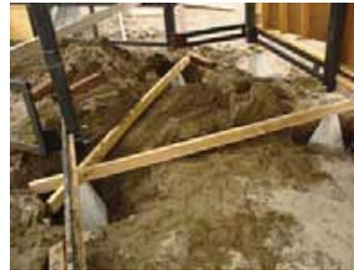
Viguetas entre apoyos que mantienen la cubícula nivelada transversalmente. Se unen a los apoyos al ser atravesadas por el esparrago y apoyarse en ellos
