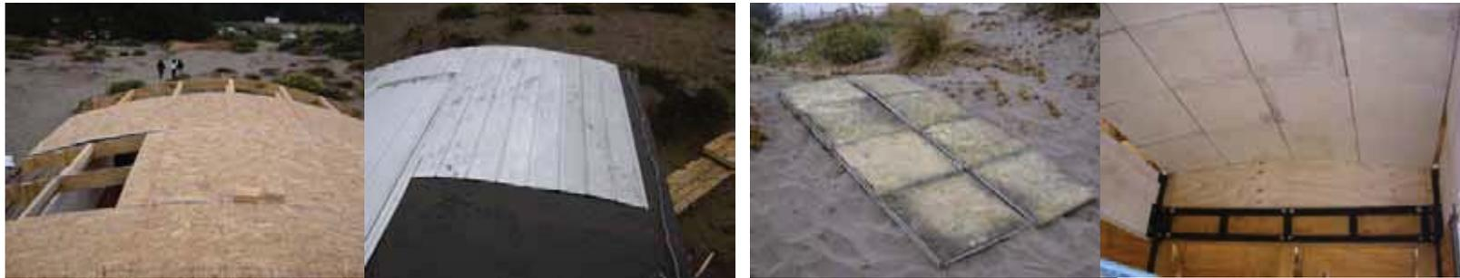
Revestimiento exterior de techo; primeramente planchas de OSB, luego papel fieltro y planchas de Zincalum 5v
