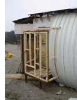
Tabiquería de la estructura; le da el espesor en su futuro revestimiento interior - exterior
