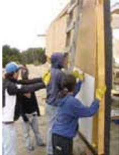
Revestimiento exterior muro rasgado. Internit sobre cajones de cholguan para proteger de la lluvia y humedad.
