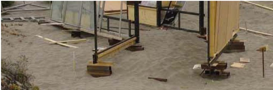
Apoyos provisionales para nivelar la Cubícula en el proceso de construcción de sus revestimientos (fierros de 100 x 100 mm)
