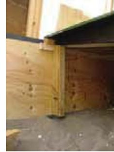
Canes y tacos que estructuran los suelos para resistir la carga sobre ellos y solucionar el desfase que se produce en la unión entre cada panel de suelo
