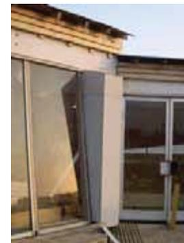
Muro bosca; ubicado en el encuentro entre los niveles (y desaplome de los ventanales con la estructura). Acoge una bosca para calefaccionar la Cubícula
