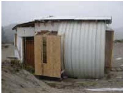
Revestimineto exterior. Alcanzamos sólo a revestir con planchas de OSB, la continuación de la Cubicula con maestros se hará cargo de concluir este revestimineto .
