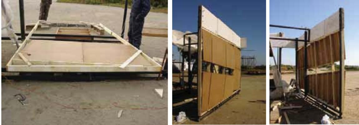
*Bastidor de madera de pino que estructura la fijación de los cajones permitiendo le ser panel en si mismo; permite incrustarlo en la estructura chasis y salir levemente del plomo de éste*
