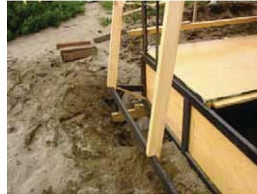
Estructura mixta. Vínculo del larguero que guía cada ventanal con la viga de cajón superior y su apoyo en la «pisadera» que recibe a estos y a los ventanales.
