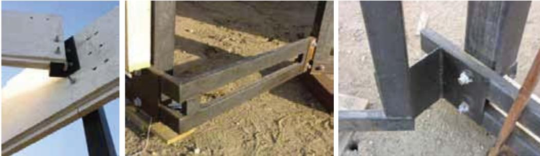
Herrajería inferior; vínculos entre pie derechos que concluyen el armado de la «estructura chasis» cerrandola y rigidizandola inferiormente.
