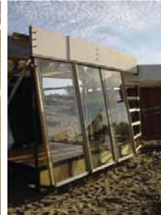
Ventanales ya instalados. Al interior espacio de guardado en su parte baja y la construcción de la «distancia de ingravidez» al ventanal.
