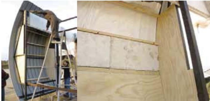
Muro ya colgado. Su aislación contiene papel fieltro y aislapol. Luego se reviste interiormente con planchas de terciado
