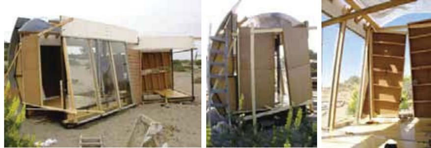
Construcción de los dos bastidores desfasados que conforman el revestimiento. Uno en el plomo de la estructura que a la vez es estructurante de ésta misma, y el segundo desfasado que construye el espacio de guardado y se estructura mediante un tensor fijado a la viga de cajón.
