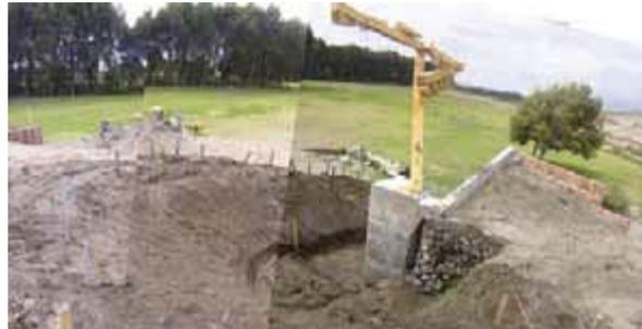
Preparación del terreno; trazado y dibujo del proyecto (curva, rampa y escaleras) sobre la arena.
