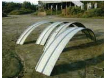
Panel CD460; restos Hospedería Suspendida. Seis paneles cuyo arco es de 4.85mts. lineales y generan una cuerda aproximada de 4.00 mts.
