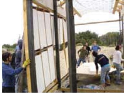
Revestimiento interior muro rasgado. Aislapol como aislante ocupando el espesor de los cajones de cholguan. Luego el revestimiento de terciado ranurado que le da temperie y terminación al interior
