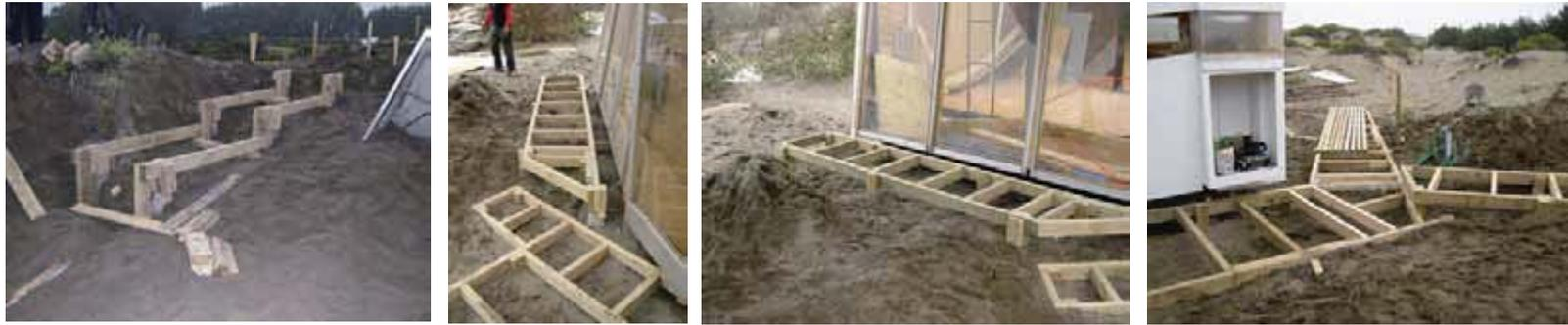
Armado de estructura para las calzadas. Se inicia con poyos enterrados en la arena que soportan las viguetas conformando la primera estructura. Luego se continua con la postura del caneado entre viguetas, todo esto con madera impregnada de 2 x 4".
