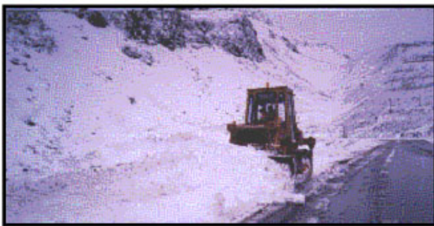
Figura 5.1. Vista del despeje del cordón lateral con bulldozer, después de un sistema frontal.
