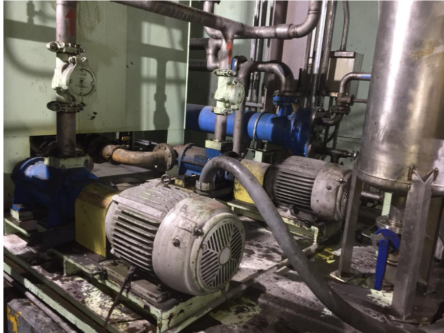
Figura 2-7: Bombas de baja presión, sistema de lubricación.
