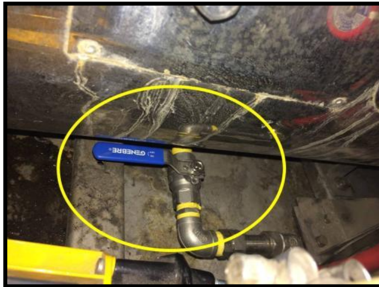
Figura 24: Mantenimiento Diario - Quinta Acción
