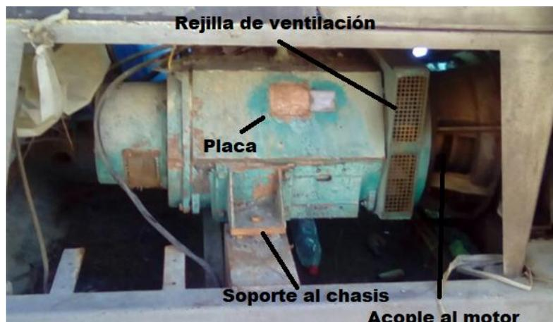
Figura 15. Alternador síncrono de grupo electrógeno marca Unelec.
