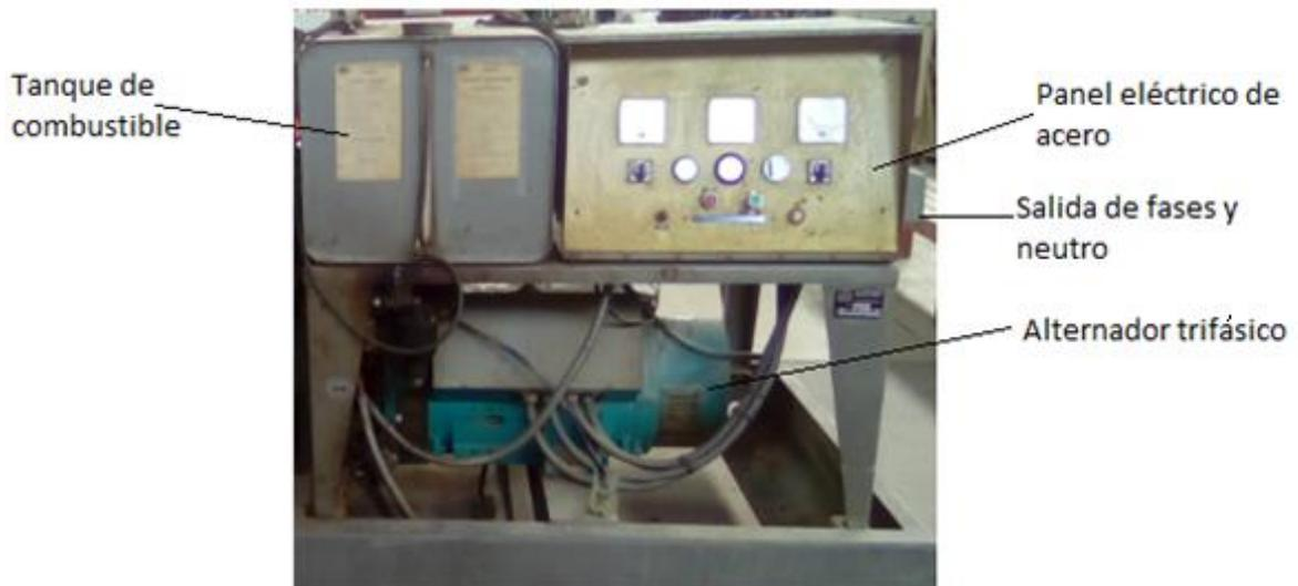
Figura 11: Panel grupo electrógeno Alsthom Dieselair 120.
