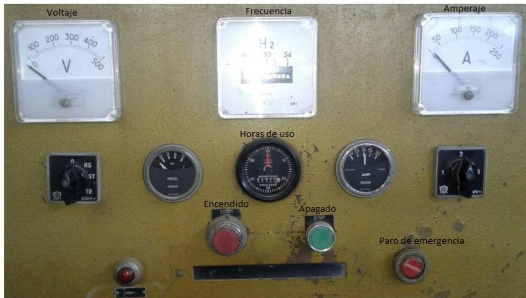
Figura 17: Indicadores del panel eléctrico.
