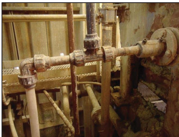
Figura 8. Línea descarga de licor desde el filtro de prensa a intervenir
