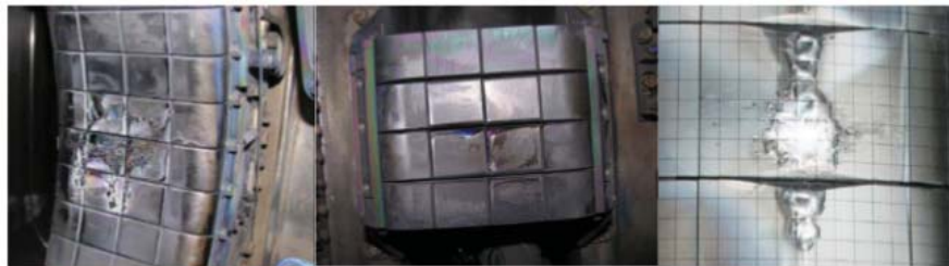
Figura 2.1: Daños en la pared del dispositivo.
