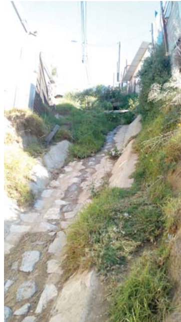
tratamiento interno de las laderas
