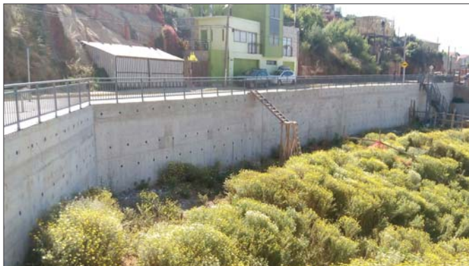
Muro de contención que sostiene la calle, Valparaíso
