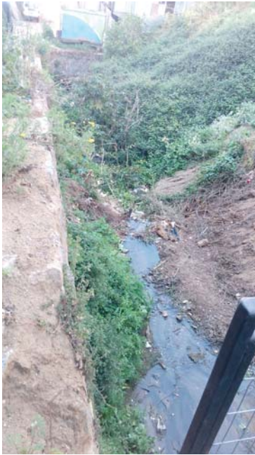
apoyamiento antes del desarenador
