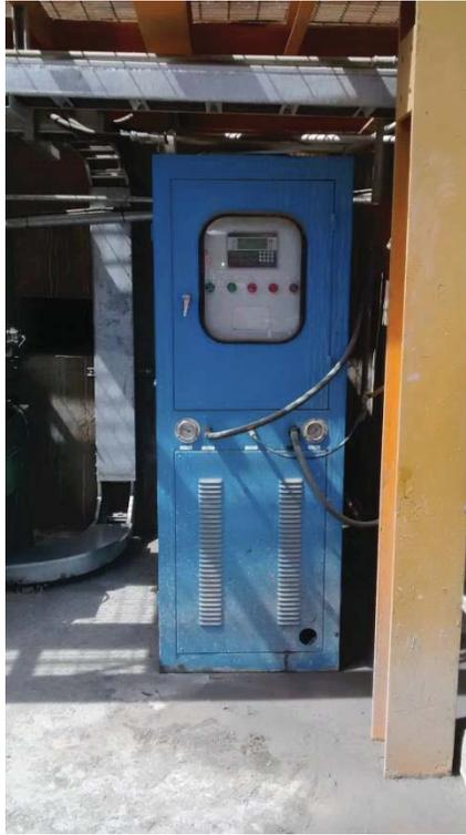
Imagen 3.10: Estación de control del sistema de lubricación piñón-corona.
