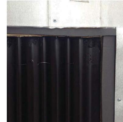
Aislante de poliestileno en el borde interno del colector
