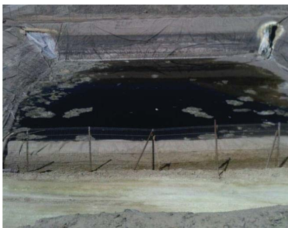
Figura 6.4: TK de Evaporación, actualmente sin utilizar
