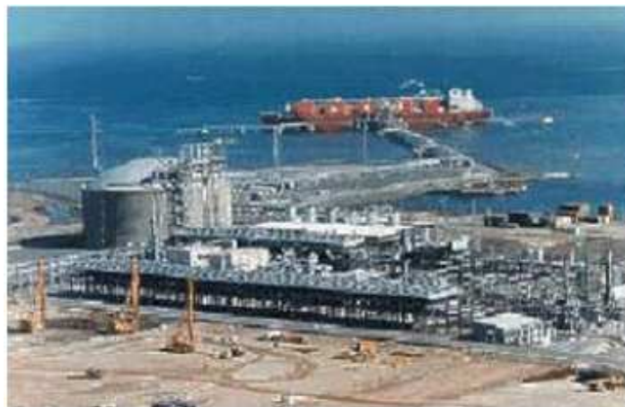
Fig. 2.1: Planta de Licuación de Gas Natural
