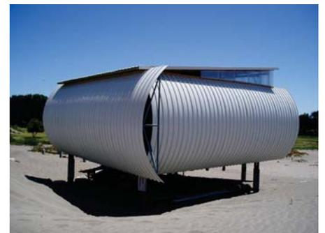
El volumen de la hospedería está cubierto, en sus caras laterales, por planchas curvas. Estas cubiertas son una forma intermedia entre el cilindro y el plano.
