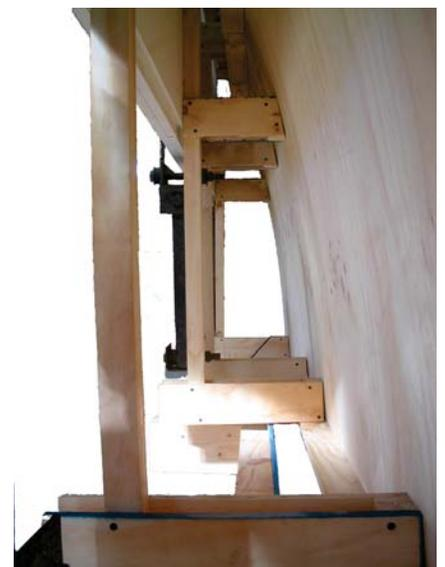
Vista lateral de la estructura superior. Anclaje superior a la viga y plancha curvada fija a los tacos
