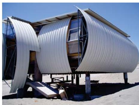
El suelo tenía la pendiente natural de la duna. Al momento de colocar las cubiertas el suelo comienza a cambiar, ya no es solamente el socavamiento particular de cada pilar. El desplazamiento del viento a través de la superficie de la hospedería comienza a socavar de manera acelerada la duna.
