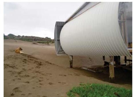
El viento tiende a disminuir la pendiente socavando la zona de mayor altura y construyendo un suelo relativamente plano debajo de la hospedería.
