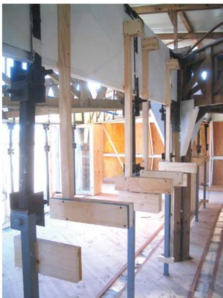
Armazón de la estructura superior fija a la viga.
