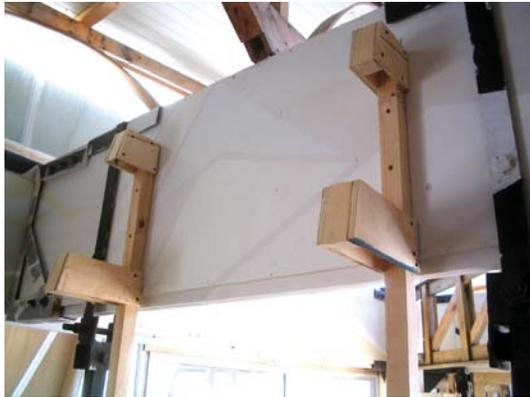
Detalle del anclaje de los listones superiores a la viga
