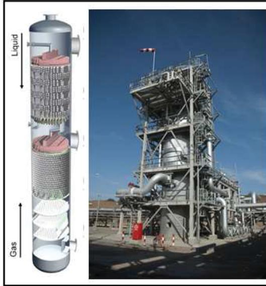
**Fig.9: Recondensador de GNL (Fuente: Elaboración propia)**
