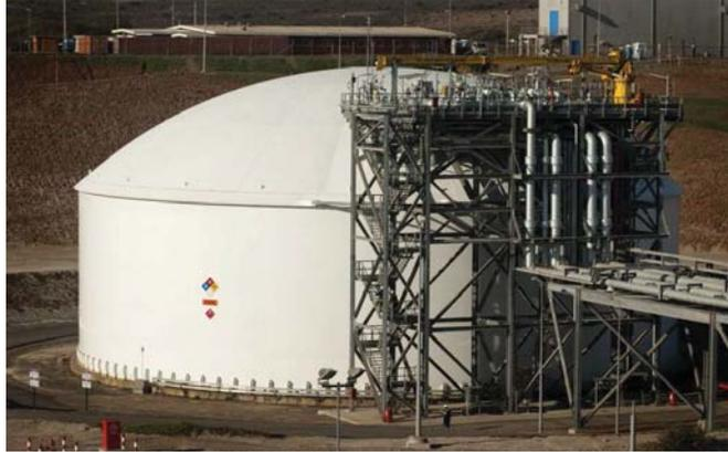
**Fig.6: Tanque almacenamiento contención simple (Fuente: Elaboración propia)**
