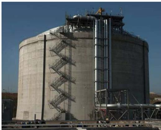
**Fig.7: Tanque almacenamiento contención completa (Fuente: Elaboración propia)**
