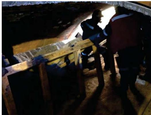
Figura N° 66: Enladrillado Bóveda.
