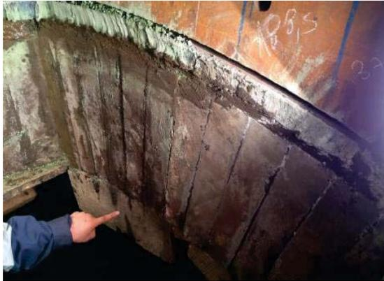
Figura N° 65: Enladrillado sector boca.
