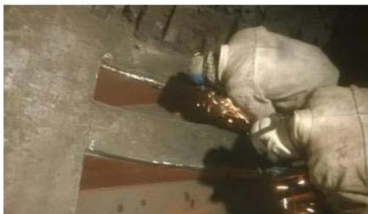
**Figura N° 44: Soldadura de piqueras.**
