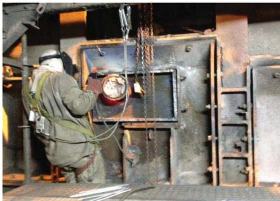
**Figura N° 55: Montaje quemador.**
