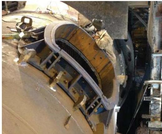
**Figura N° 35: Nueva Boca Montada.**
