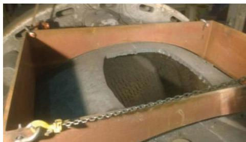
**Figura N° 42: Nuevo Vano Boca de Gases y Nuevo Cajón montado.**
