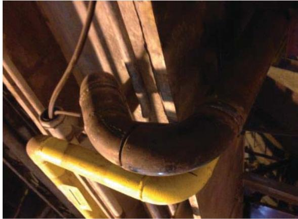
**Figura N° 62: Línea de aire diámetro 3''.**
