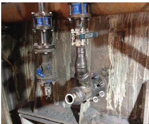
**Figura N° 48: Quemador sumergido.**
