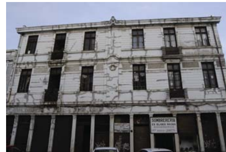
EDIFICIO en calle Juana Ross, Reparaciones a fisuras post-terremoto 2010
