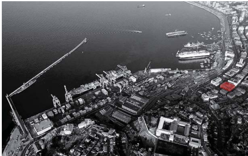
Foto aerea del puerto de Valparaíso con el mercado evidenciado
