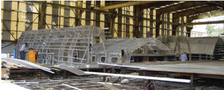
Figura 328. Construcción de cuadernas y refuerzos longitudinales del casco superior. Fuente: Boote y Mascia. Structural Design of Innovative Passenger Vessel. Italia. Departamento de Ingeniería Naval y Tecnología Marina de la Universidad de Génova. Disponible en: http://www.icmrt07.unina.it/Proceedings/Papers/B/04.pdf
