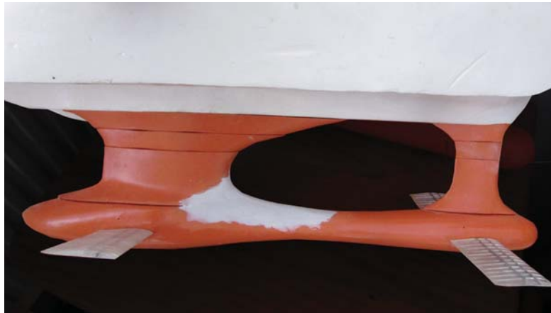
Figura 486. Imagen de la intervención de la unión entre el arbotante y el bulbo. Se rellena ese espacio con “masilla mágica”. Fuente: propia
