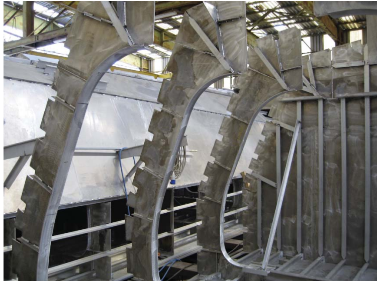
Figura 327. Imagen de las cuadernas del casco lateral en construcción. Fuente: Boote y Mascia. Structural Design of Innovative Passenger Vessel. Italia. Departamento de Ingeniería Naval y Tecnología Marina de la Universidad de Génova. Disponible en: http://www.icmrt07.unina.it/Proceedings/Papers/B/04.pdf
