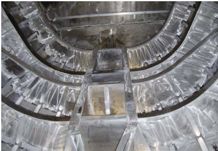
Figura 329. Construcción de la columna de popa que conecta con el casco. Fuente: Boote y Mascia. Structural Design of Innovative Passenger Vessel. Italia. Departamento de Ingeniería Naval y Tecnología Marina de la Universidad de Génova. Disponible en: http://www.icmrt07.unina.it/Proceedings/Papers/B/04.pdf
