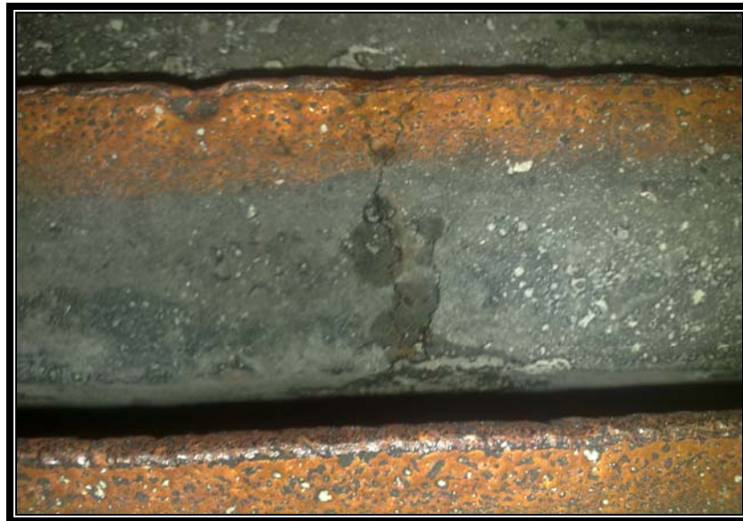
Fig N°21. Grieta en un ánodo de cobre.
