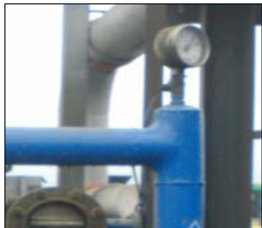
Figura 29: Flujómetro placa orificio.
