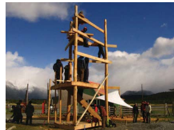
Fotografía del registro común, Construcción de la torre poniente, esta tiene 4 niveles.
