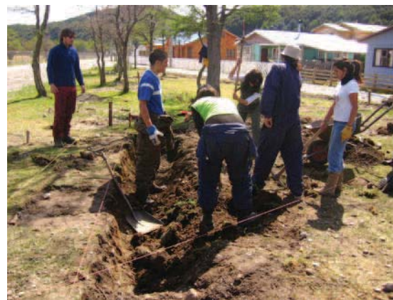
Días de obra, lo colectivo, construcción de los talud. Fotografía del registro común
